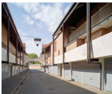
En haut, les nouvelles façades sur jardin. En bas, l'allée des Coursives qui dessert les box de stationnement occupant les rez-de-chaussée.
