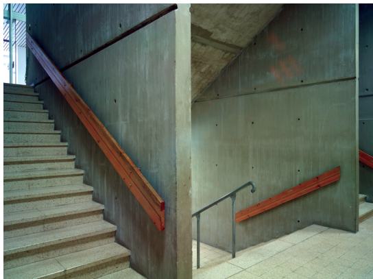
Le jeu des escaliers de circulation, en béton brut de décoffrage [Pierre Thibaut, mai 2015]
