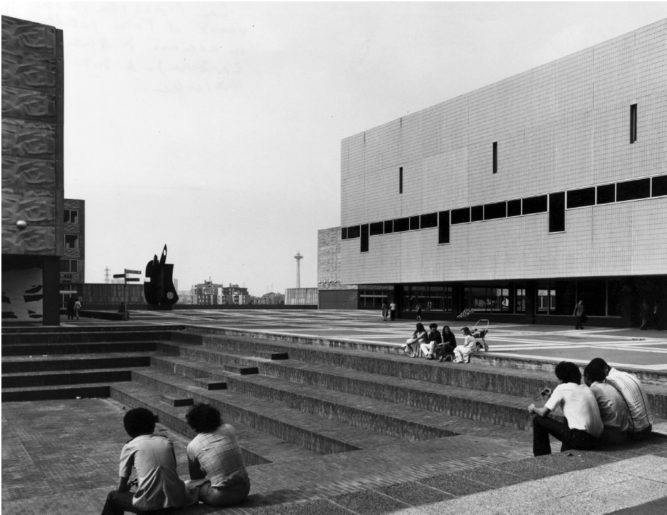
Façade de la bibliothèque sur le forum, n.d. (vers 1976)
