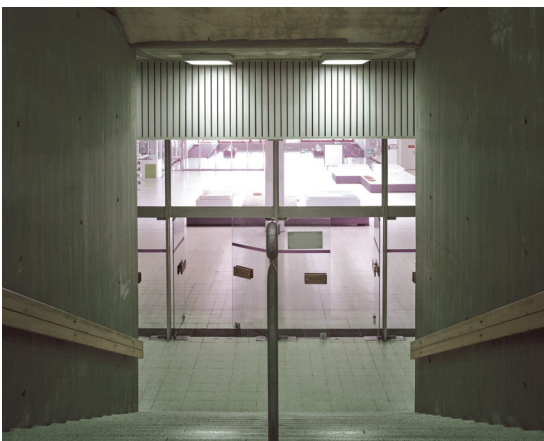
La volée centrale de l'escalier conduisant au hall [Pierre Thibaut, mai 2015]
