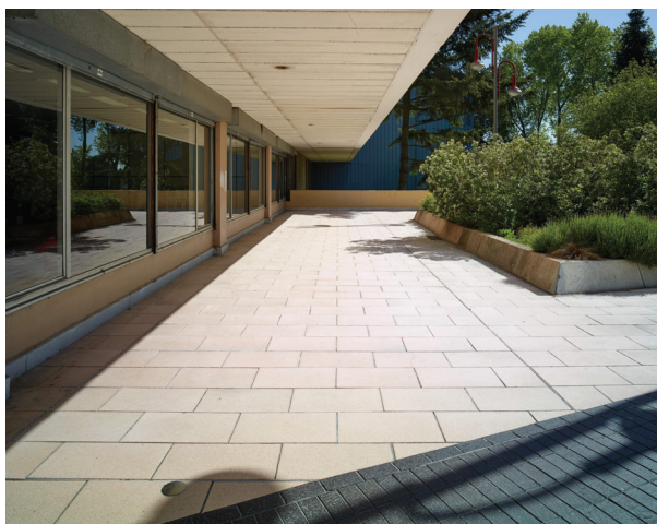
Le surplomb généreux du 1 er étage, protégeant du soleil et des intempéries [Pierre Thibaut, mai 2015]
