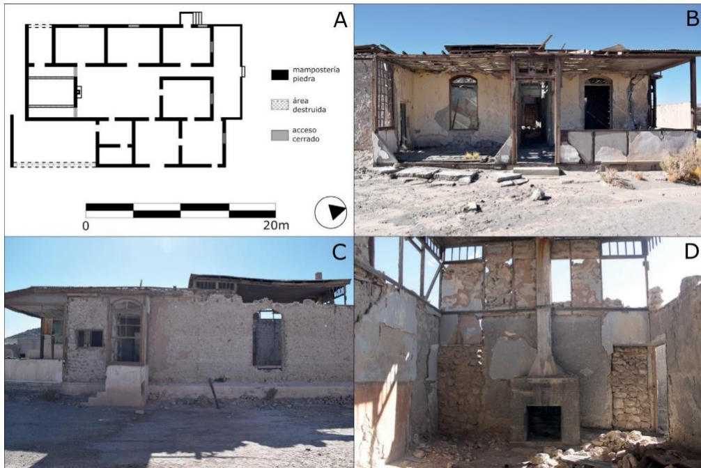
Figura 5. Buenaventura, edificio de administración conocido como la "casa de los jefes". A. Plano de la estructura. B. Vista hacia el sur, entrada principal. C. Vista hacia el este. D. Interior. Fuente: Rivera 2017.
