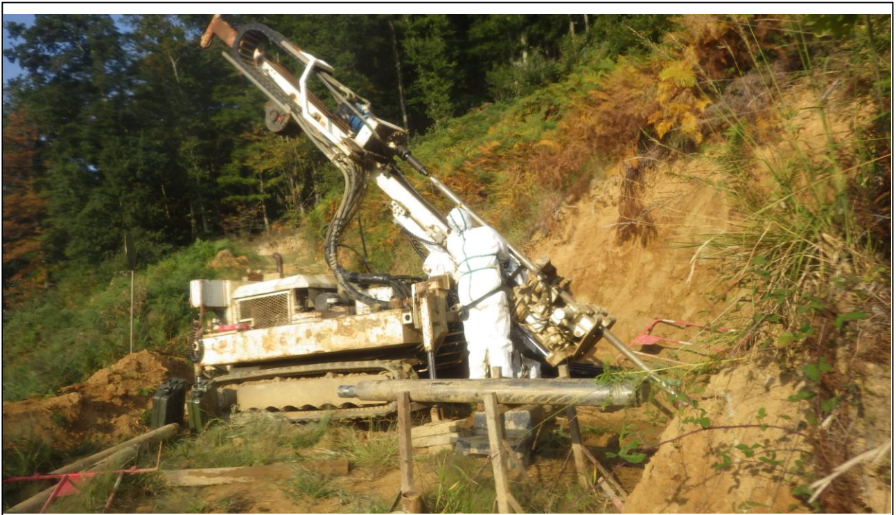
Figure 4: opération de carottage en sous section IV lors d'un repérage d'amiante environnemental. Source Cerema
