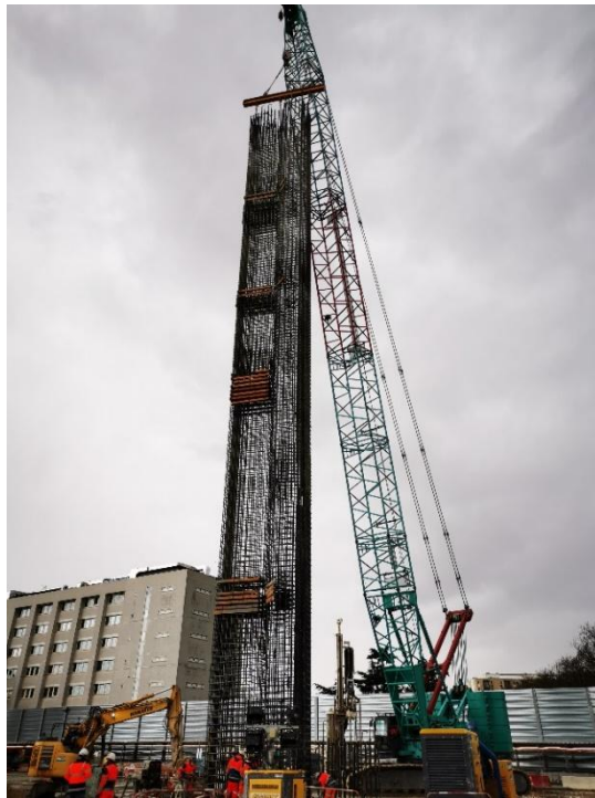
Figure 11. Levage des cages en Y assemblées
