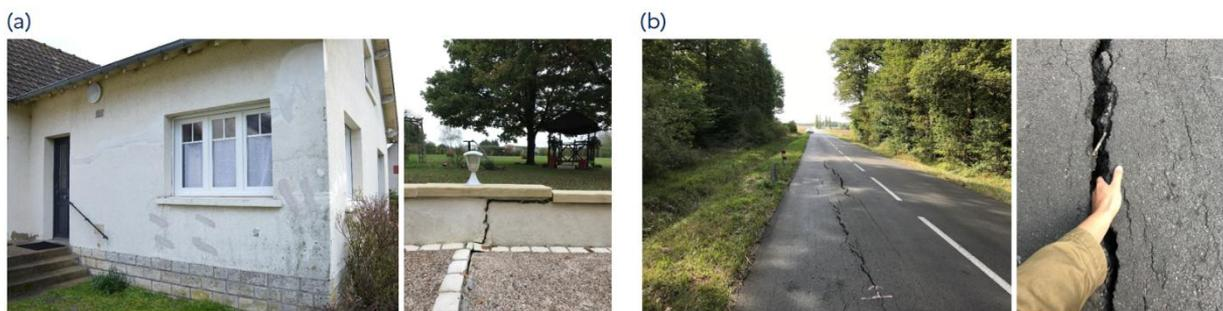
Figure 2. Exemples de dommages imputables à la sécheresse et au phénomène de RGA : (a) fissuration de la structure d'une maison, (b) fissuration d'une route départementale.
