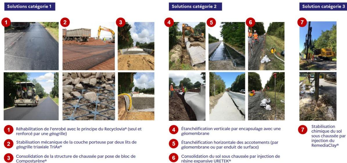
Figure 5. Illustration des solutions de remédiation testées à ce jour dans le cadre du projet ORSS.
