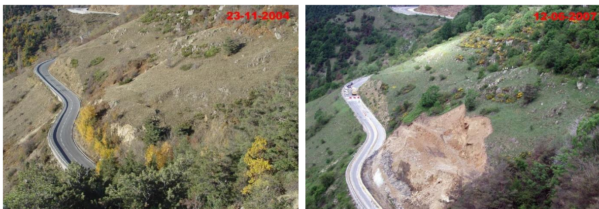
Figure 4. Lacets du Pallat, avant et après le glissement de terrain de 2007.
