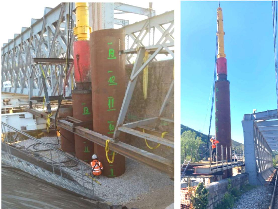
Figure 1. Mise en fiche des tubes définitifs par battage
