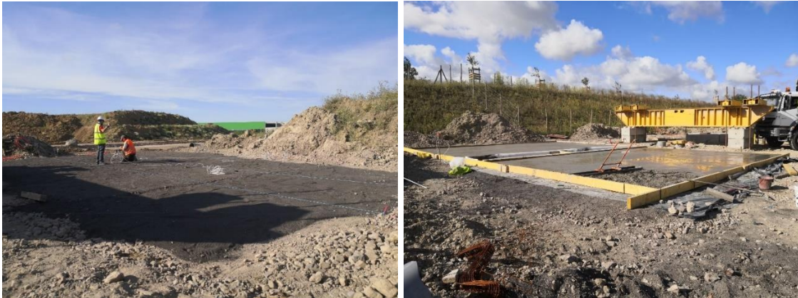
Figure 4. Photos de préparation de la plateforme et coulage
