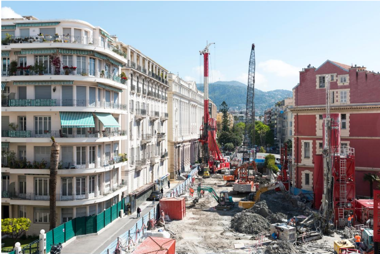
Figure 6. Mise en œuvre du jet grouting
