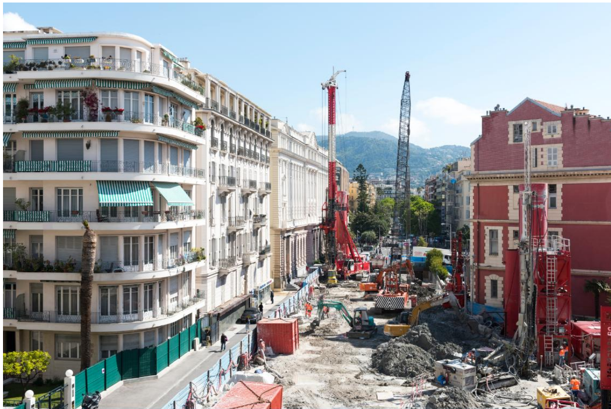
Figure 6. Mise en œuvre du jet grouting
