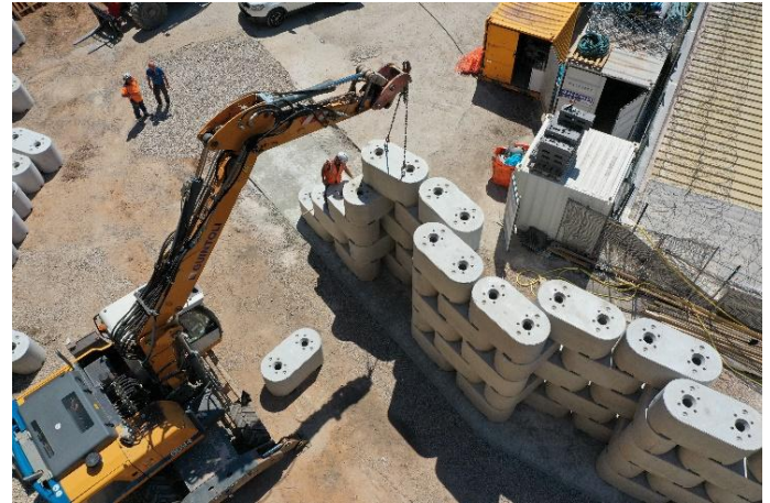
Figure 7 : Montage du mur a) Empilement des blocs au niveau du redan vertical b) Placement d'un bloc avec l'engin de levage de type pelle mécanique
