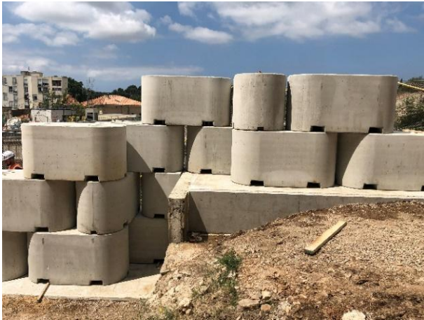
Figure 7 : Montage du mur a) Empilement des blocs au niveau du redan vertical b) Placement d'un bloc avec l'engin de levage de type pelle mécanique
