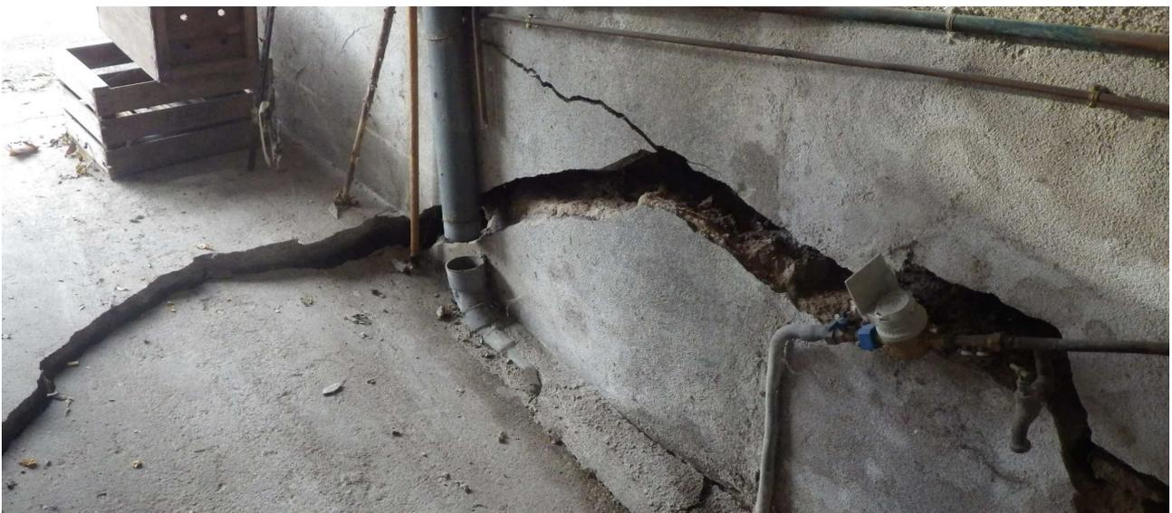
Figure 2 : Effondrement et dégradation du mur du pignon nord du bâtiment
