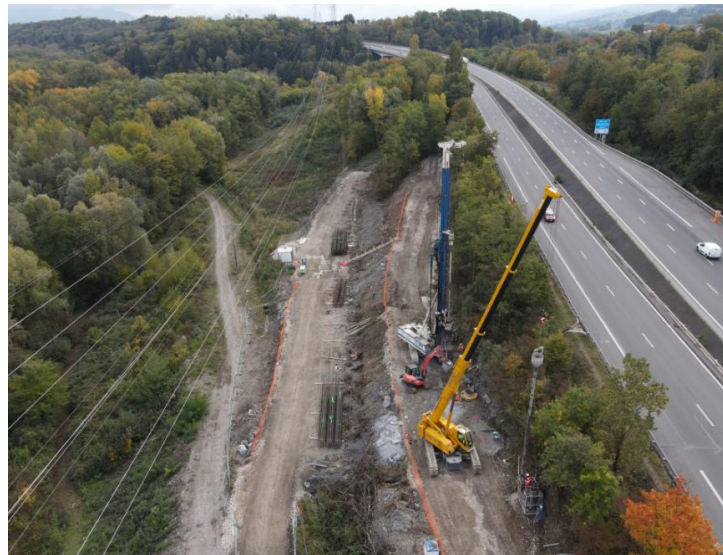
Figure 2. Illustration des travaux de confortement du talus d'Etrembières
