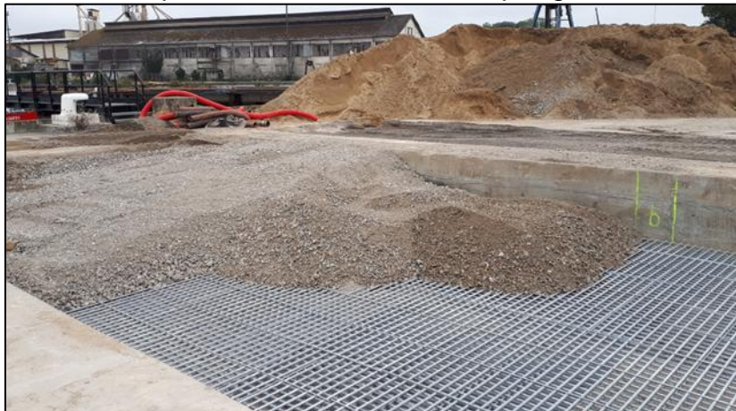
Figure 10. Mise en œuvre du renforcement horizontal
