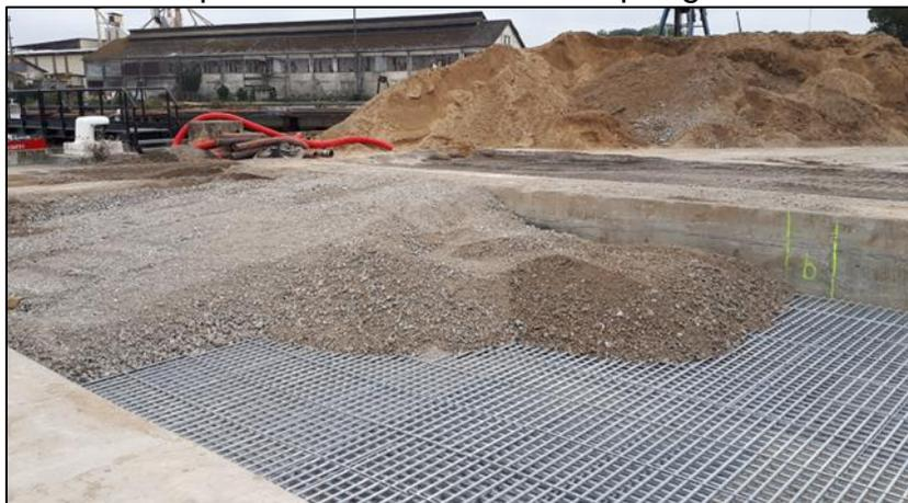
Figure 10. Mise en œuvre du renforcement horizontal
