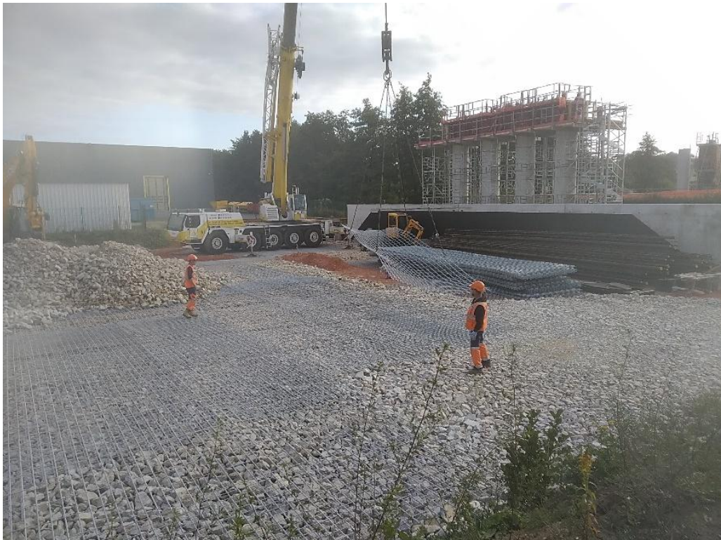
Figure 7: Treillis soudés en cours de positionnement à Ferrières-en-Bray
