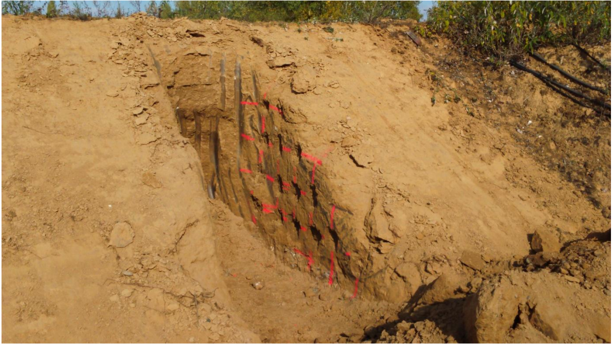
Figure 2. Tranchée excavée dans le talus de la digue en limon traité (T2) et points de prélèvement d'échantillons remaniés.
