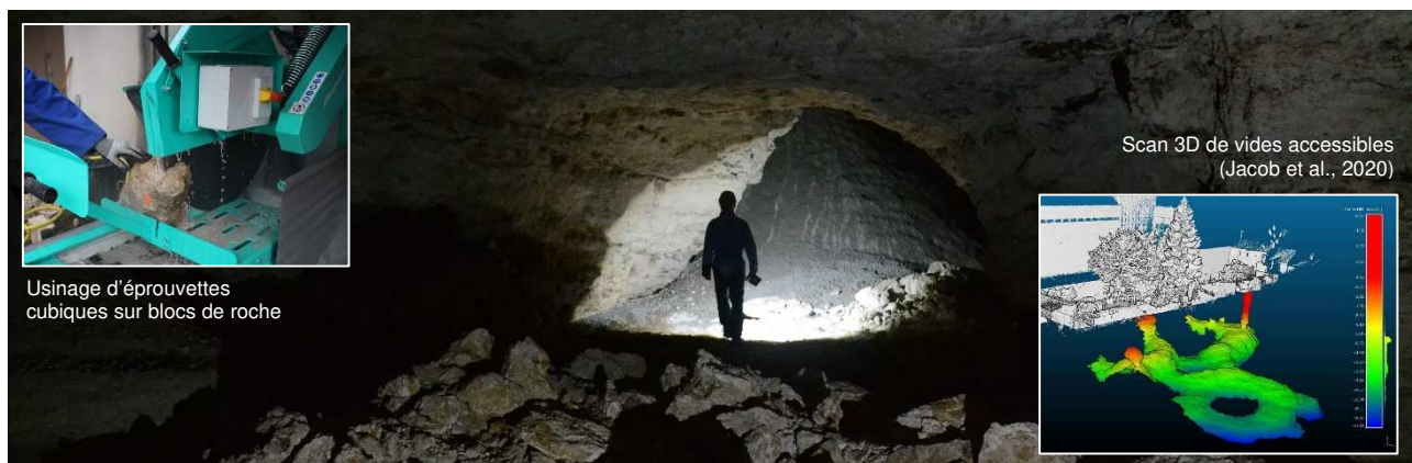
Figure 1 : vue générale de la carrière souterraine redécouverte et investigations
