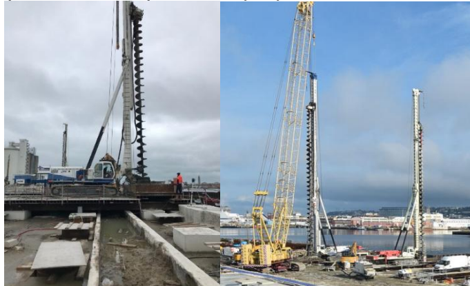
Figure 6. Forage des pieux tarière creuse en zone Quai
