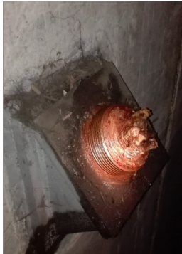
Figure 8. Tête filetée de tirant de la M980
