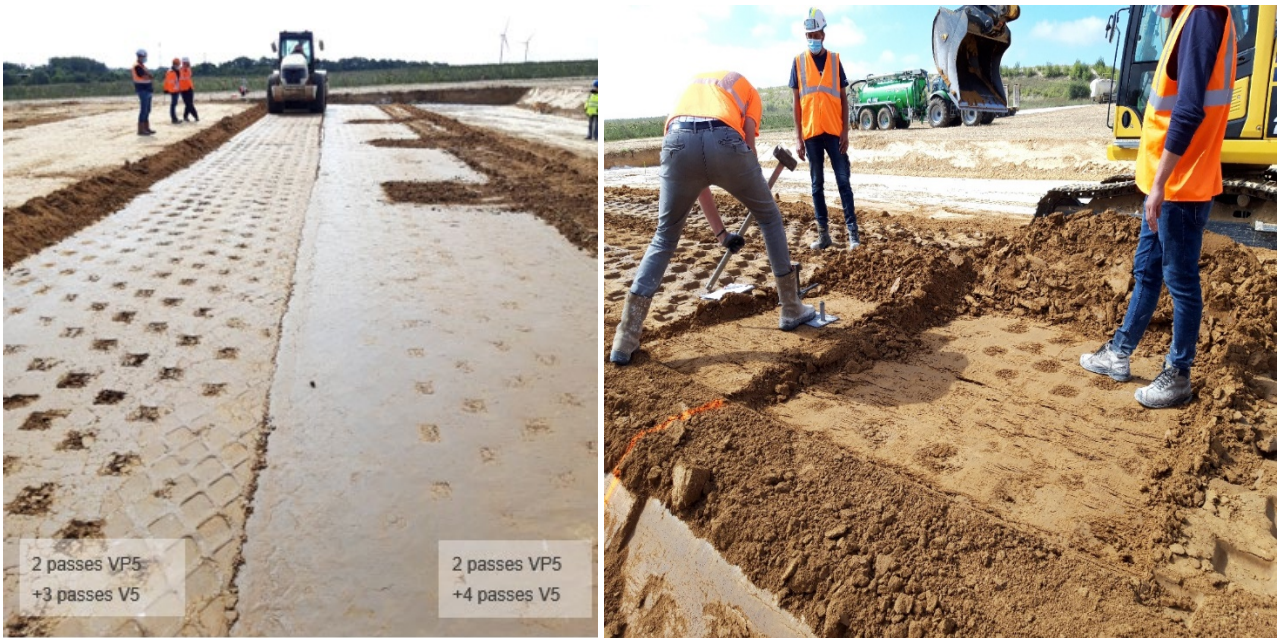
Figure 5. A gauche : suivi de l'évolution de l'état de surface avec le nombre de passes. A droite : réalisation de différents paliers pour la mesure de densité en profondeur.
