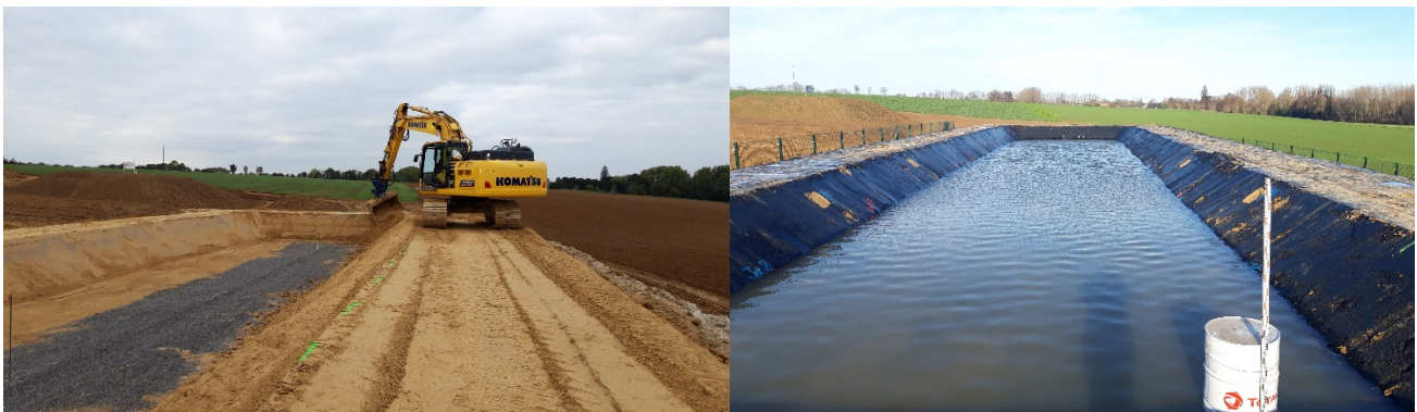
Figure 3. A gauche : bassin en cours de réalisation. A droite : bassin en cours de remplissage.
