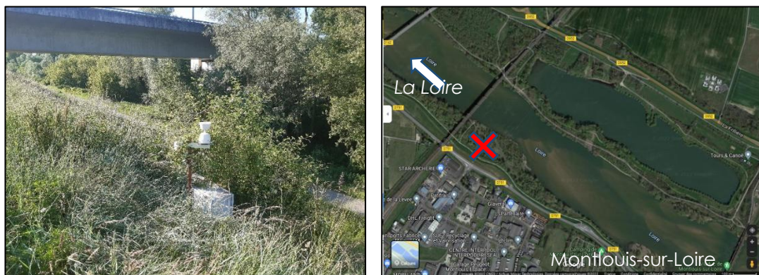
Figure 1. Vue de la digue et de la station météorologique au droit du secteur instrumenté et localisation générale de l'instrumentation ©Google Maps (2022).
