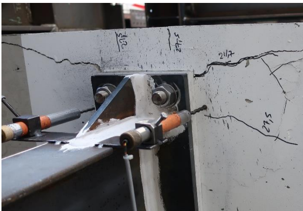
c) Concrete edge failure
