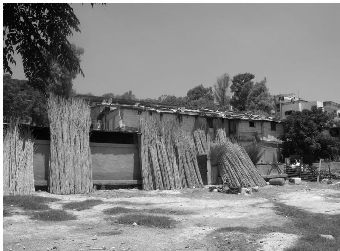
Bâtiments pour l'élevage de poulets convertis et compartimentés en une vingtaine d'unités de location
