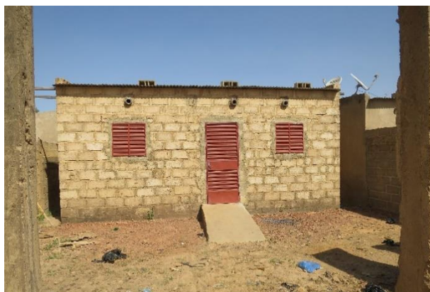
Maison à plan rectangulaire avec des murs en blocs de sable-ciment et toiture en tôles (Ouagadougou). – © Enrique Sevillano Gutiérrez, CRAterre
