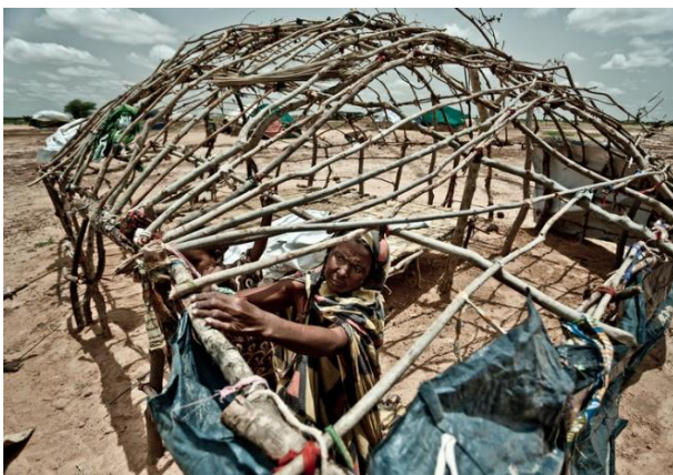
Autoconstruction d'un abri nomade au camp de réfugiés Mentao Nord en 2012 (Région Sahel) – CC Oxfam
