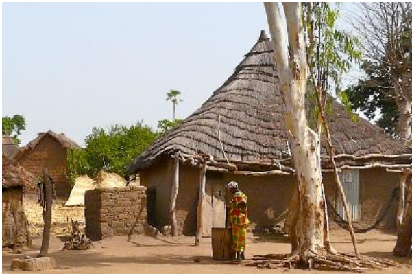
Maisons Gan à plan orthogonal à Gaoua (Région Sud-Ouest) : toiture à deux pentes (à gauche) et à quatre pentes (à droite) – CC Rita Willaert
