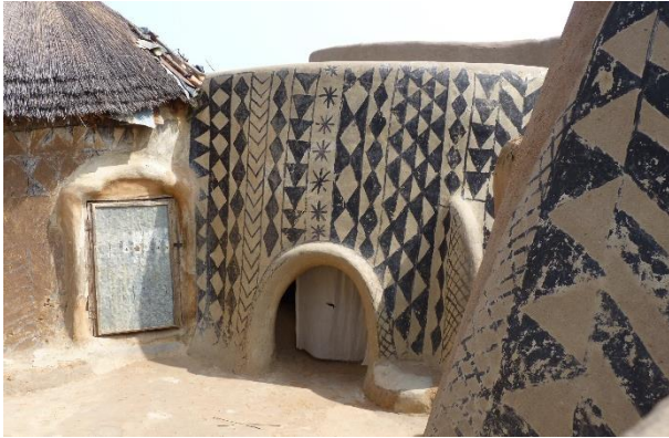
Concession Kassena à Tiébélé (Région Centre-Sud) ou les sols extérieurs sont soigneusement travaillés – © Sébastien Moriset, CRAterre
