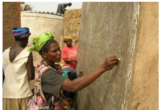
L'entraide est centrale dans beaucoup de zones du pays pour les travaux de construction (Tiébélé, Région Centre-Sud) – © CRAterre
