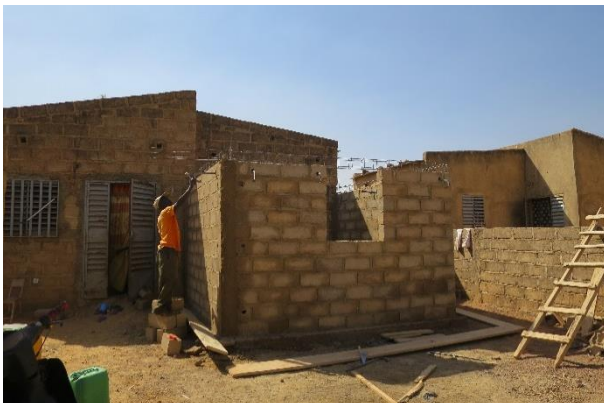
Maisons pistolets à gauche et à droite ; celle de gauche avec une extension en cours (Oaugadouyou) – © Enrique Sevillano Gutiérrez, CRAterre
