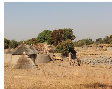
Toiture en chaume et adobes prêts à être utilisés pour la construction d'une maison – CC Carsten ten Brink
