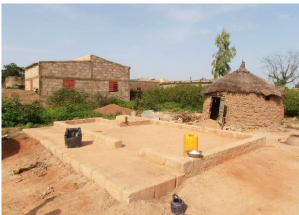
Maison en blocs de sable ciment avec ossature en béton armé et toiture en tôles (gauche) à côté d'une construction à plan circulaire avec murs en adobe et toiture conique en chaume (droite). Les deux constructions entourent une troisième en cours de construction à Fada N'Gourma (Région Est) – © Enrique Sevillano Gutiérrez, CRAterre
