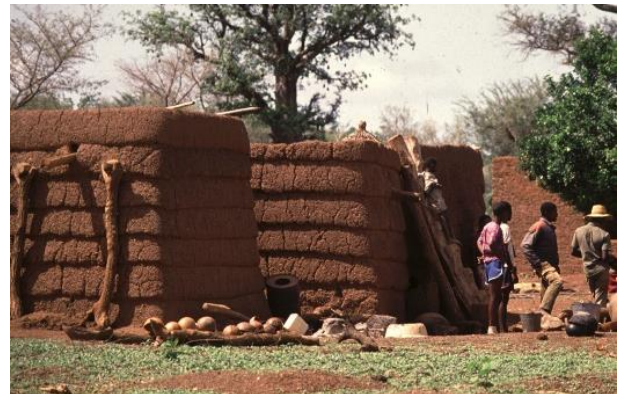
Maisons avec des murs en terre empilée et ossature porteuse en poteaux-poutres de bois – © CRAterre
