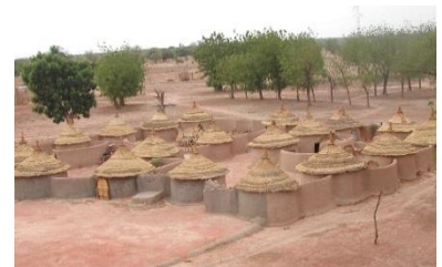
Dans les concessions rondes et irrégulières les maisons et les murs s'articulent entre eux créant un ensemble résistant aux sollicitations (Kokologho, Région Centre-Ouest) – © Wilfredo Carazas Aedo - CRAterre
