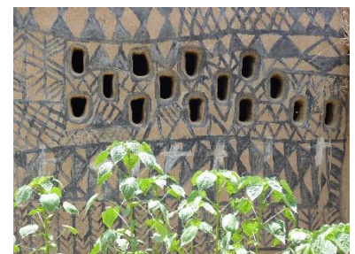
Percées murales pour l'aération intérieure à Tiébélé (Région Centre-Sud) – © Sébastien Moriset - CRAterre
