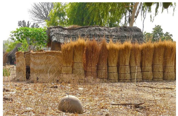
Maison Gan près de Gaoua avec fibres végétales dans la clôture, dans la toiture (à deux pentes) et stockées à côté de la concession (Région Sud Ouest) – CC Rita Willaert
