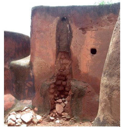
L'entretien périodique des murs (enduisage, rebouchage de fissure, entretien du pied des murs, entretien du côté exposé aux pluies battantes, etc., reste essentiel pour une durabilité accrue des constructions (Région Centre-Sud) – © CRAterre
