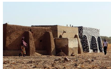
Constructions avec des contreforts pour la stabilité des murs (Tangassoko, Région Centre-Sud) – CC Carsten ten Brink
