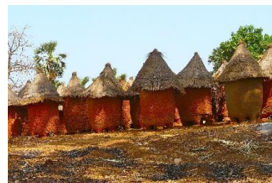
Dans certaines zones les greniers sont tous disposés à l'est des concessions (direction de provenance des vents dominants) pour éviter la possibilité de propagation vers les greniers des incendies qui pourraient surgir dans les cuisines (Greniers Sénoufo – Régions Hauts-Bassins et Cascades) – CC
