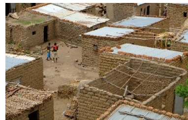
Les acrotères aident à éviter l'arrachement des tôles par les forts vents (Kouro, Région Boucle du Mouhoun) – © Nuria Sánchez Muñoz, CRAterre
