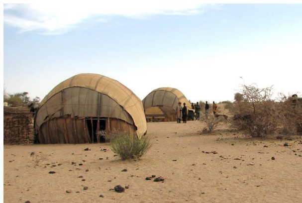
Murs en fibres végétales dans des constructions temporaires Peul – © Corine Lundqvist
