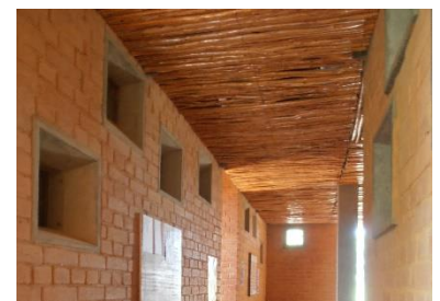
Faux-plafond dans un poste de santé près de Ziniaré (Région Plateau-Central), construit par l'architecte Francis Kéré – © Enrique Sevillano Gutiérrez, CRAterre
