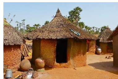
Les toitures des maisons Sénoufo (entre autres) ont des pentes dont l'inclinaison varie pour permettre à l'eau d'être évacuée plus facilement avec une pente plus prononcée au centre de la toiture et moins prononcée en descendant. De plus, les débords de toiture sont suffisamment importants de façon à protéger les murs dans cette zone assez pluvieuse. Maison Sénoufo (Région Cascades) – CC Rita Willaert
