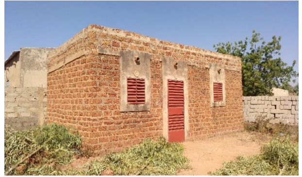
Maison à plan rectangulaire avec des murs en BLT et toiture en tôles (Ouagadougou) – © Enrique Sevillano Gutiérrez, CRAterre
