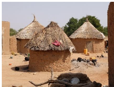
Les constructions à plan circulaire ont plus de résistance face au vent, elles ont une meilleure stabilité et se déforment moins facilement. De même, les constructions à faible hauteur résistent mieux aux vents (Région Centre-Ouest) – © Olivier Moles, CRAterre
