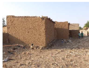
Les murs exposés à l'est (côté des pluies battantes) sont protégés avec des enduits plus performants (Région Centre-Ouest) – © Olivier Moles, CRAterre
