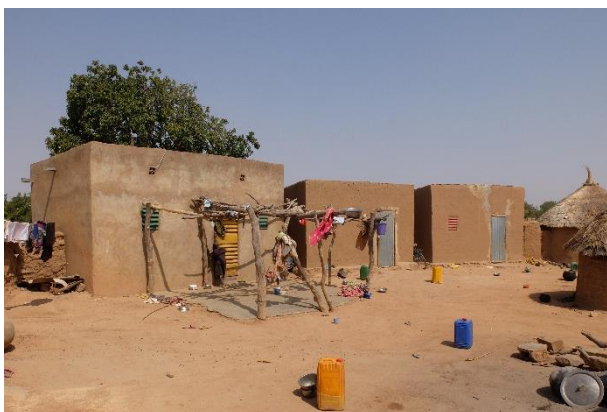
Maisons à plan rectangulaire en adobe avec toiture en tôles (Région Centre-Ouest) – © Olivier Moles, CRAterre
