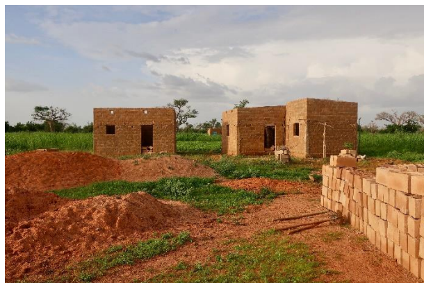
Maisons en blocs de sable-ciment en cours de construction (Région Centre-Nord) – © María Lidón de Miguel
