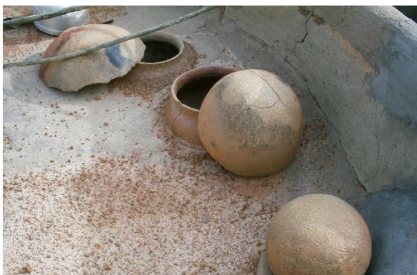
Ouvertures zénithales dans une maison Kassena (Tiébélé, Région Centre-Sud) – © Wilfredo Carazas Aedo, CRAterre
