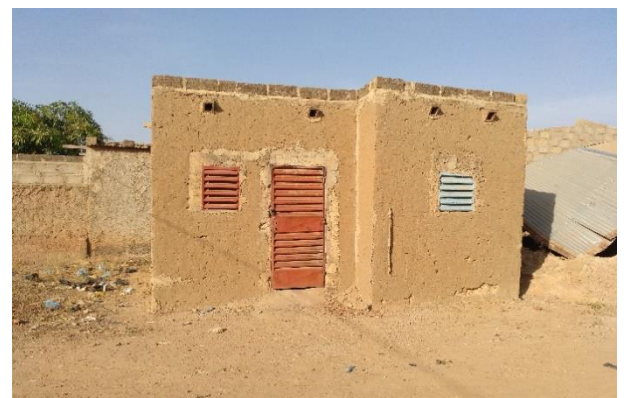
Maison en adobe avec des ouvertures métalliques en persienne (type naco), très communes dans les maisons contemporaines (Ouagadougou) – © Enrique Sevillano Gutiérrez, CRAterre
