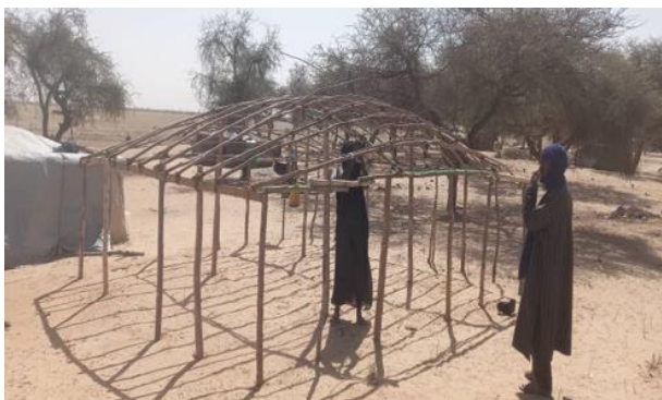
Prototype d'abri nomade. Montage de l'ossature – © Cluster Abris Burkina Faso
