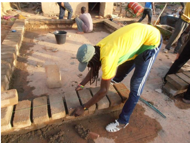
Maison en adobe avec soubassement en blocs de sable ciment et barrière capillaire en polyane en cours de construction à Fada N'Gourma (Région Est) – © Enrique Sevillano Gutiérrez, CRAterre
