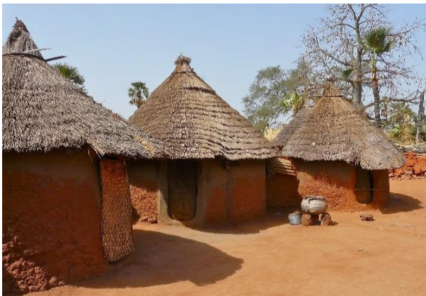
Constructions à plan circulaire et toiture conique en pays Sénoufo (Région Cascades et Hauts Bassins) – CC Rita Willaert
