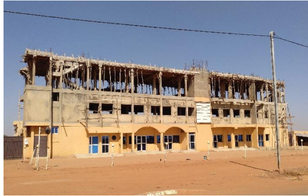
Immeuble en cours de construction à Ouagadougou – © Enrique Sevillano Gutiérrez, CRAterre
