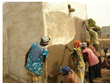
Travail communautaire des femmes Kassena pour la réalisation d'enduits de finition (Tiébébé, Région Centre-Sud) – © CRAterre
