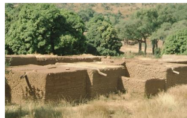
Les toitures terrasses ont des pentes permettant l'évacuation facile de l'eau de pluie et ont des gargouilles qui éloignent l'eau des murs (Houndé, Région Hauts-Bassins) – © Thierry Joffroy - CRAterre
