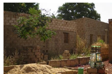
La construction des maisons en parpaings prend parfois des années. Ce n'est pas un problème si la qualité des blocs est bonne (Ouagadougou) – © Enrique Sevillano Gutiérrez - CRAterre
