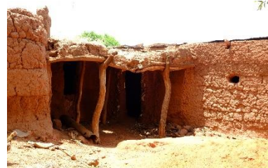
Les concessions sont en évolution, des petits cours se transforment en espace couvert, puis éventuellement en chambre (Koumi, Région Hauts-Bassins) – © Nuria Sánchez Muñoz - CRAterre
