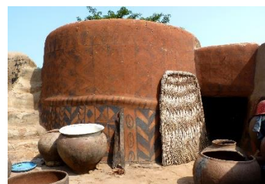
Certaines constructions Kassena ont des bandes horizontales (des adobes ou des cordeaux) qui renforcent les murs empêchant les fissures verticales – © Sébastien Moriset - CRAterre
