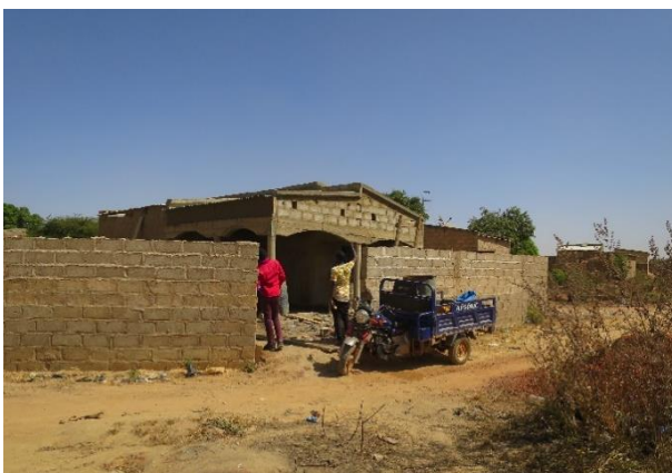
Villa en cours de constructions, avec ossature en béton armé, murs en blocs de sable-ciment et toiture en bac acier (Ouagadougou) – © Enrique Sevillano Gutiérrez, CRAterre
