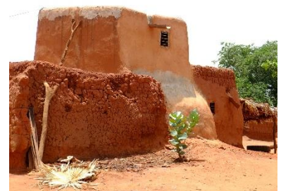
Construction à étage en bauge avec des murs en rez-de chaussée beaucoup plus larges qu'à l'étage, ce qui renforce la stabilité (Koumi, Région Hauts-Bassins) – © Nuria Sánchez Muñoz - CRAterre
