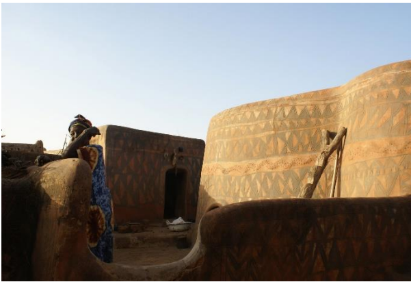
Murs en terre façonnée dans une concession Kassena (Région Centre-Sud) – CC - Guillaume Colin & Pauline Penot
