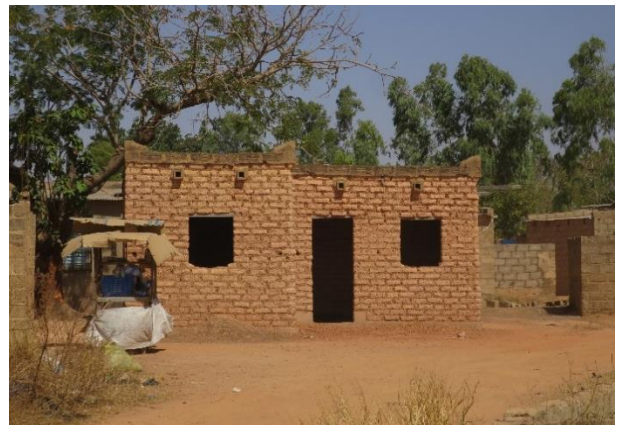
Maison en adobe en cours de construction à Ouagadougou – © Enrique Sevillano Gutiérrez, CRAterre
