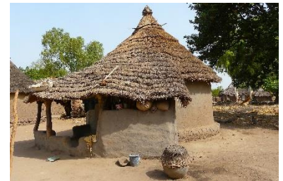
Couverture végétale dans une maison Gan près de Gaoua (Région Sud-Ouest). Ce type de couverture offre une isolation qui permet de vivre agréablement à l'intérieur de la maison. De plus, cette maison a une véranda couverte mais aérée où ont lieu beaucoup d'activités quotidiennes – CC Rita Willaert
