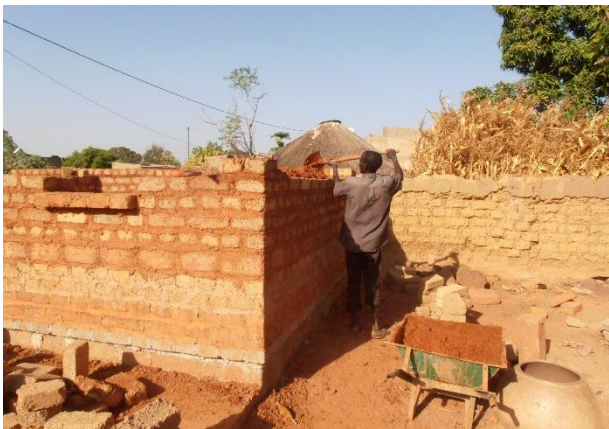
Chantier dans le marché informel (Fada N'Gourma, Région Est) – © Enrique Sevillano Gutiérrez - CRAterre
