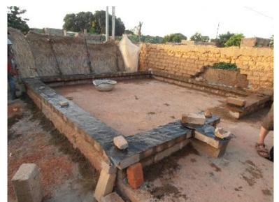
Cette maison (dont les murs seront en adobe) a une fondation en blocs de ciment pleins, plus une plateforme surélevée par rapport au terrain environnant, plus un soubassement en blocs de ciment pleins et une barrière capillaire en film polyane pour éviter les remontées capillaires dans les murs en adobe (maison à Fada N'Gourma, Région Est) – © Enrique Sevillano Gutiérrez, CRAterre
