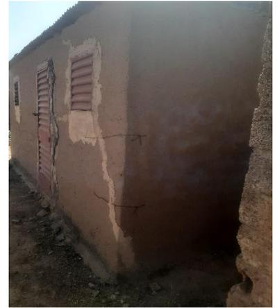
Les ouvertures sont souvent des points de faiblesse dans les constructions : distance insuffisante avec les angles ou entre ouvertures, absence de linteaux, mauvais ancrage aux murs... (Ouagadougou) – © Yaam Solidarité
