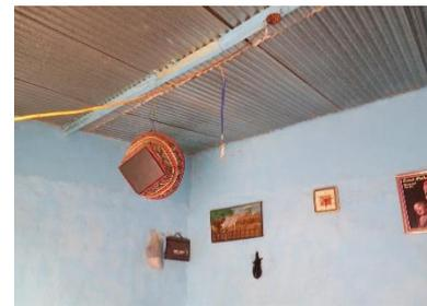
Les familles font des économies dans le nombre de chevrons utilisés pour les toitures en tôle (minimum un chevron à chaque extrémité et un au milieu) au détriment de la stabilité de ces toitures et la durabilité de l'ensemble du bâtiment (Ouagadougou) – © Enrique Sevillano Gutiérrez - CRAterre
