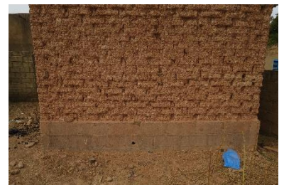
Construction avec soubassement en blocs de sable-ciment et élévations des murs en adobe (Boassa, Ouagadougou) – © Enrique Sevillano Gutiérrez - CRAterre
