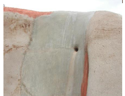
Comme le montrent ces deux images, l'entretien des descentes d'eau dans les toitures terrasses est essentiel pour la durabilité des constructions (Région Centre-Sud) – © Wilfredo Carazas Aedo - CRAterre
