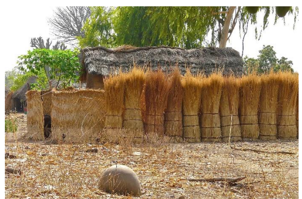
Maison Gan près de Gaoua avec fibres végétales dans la clôture, dans la toiture (à deux pentes) et stockées à côté de la concession (Région Sud Ouest) – CC Rita Willaert
