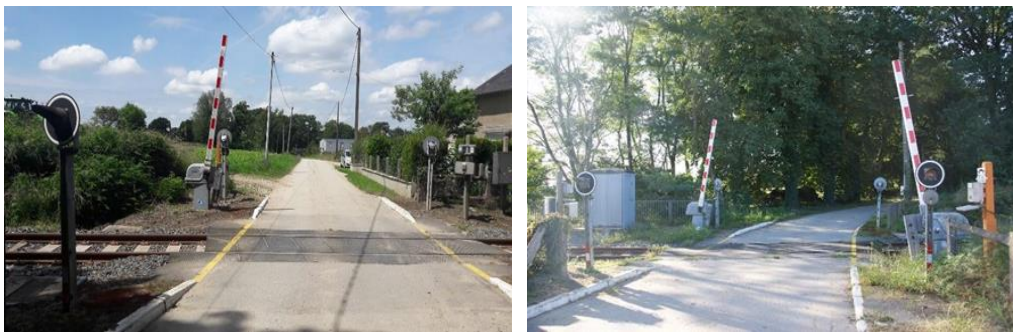
Figure 2 Level crossing "PN 449" of Brec'h
