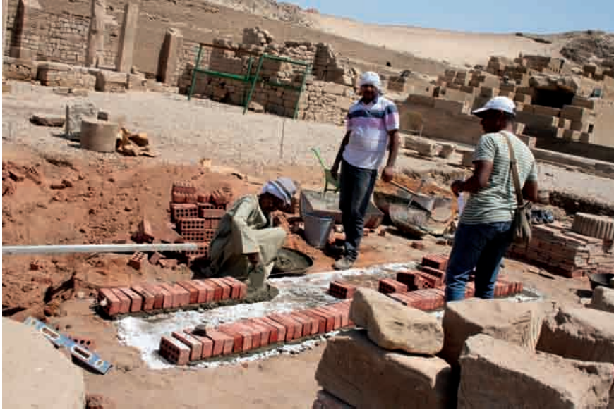
Figure 1 : Construction du mastaba n° 9 (CC-BY Ali Abdelhalim).
