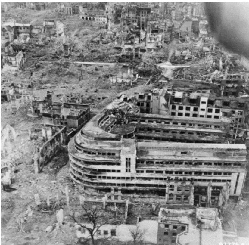
FIG. 1. Cologne (Köln), vue aérienne au printemps 1945, à gauche les restes du monastère S. Kolumba (Futur Musée Kolumba d'Art Sacré, arch. Peter Zumthor, inauguré en 2007). Au milieu, on note que le bâtiment moderniste en béton armé, a mieux résisté aux ravages des bombardements. Ce type de situations a favorisé la tendance de la reconstruction des villes sinistrées en accord avec les théories et les techniques de construction du mouvement moderne (Chartes d'Athènes de Le Corbusier, 1931, béton armé, etc).
