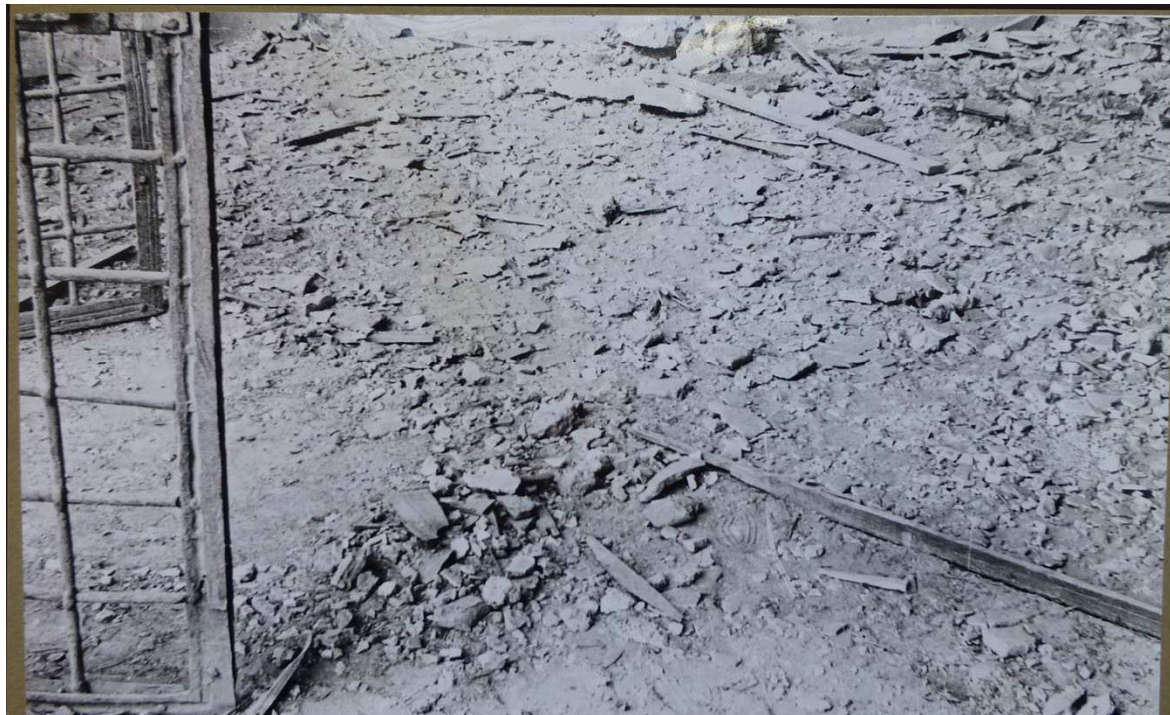
FIG. 3. Viterbo (Italie), chapelle Mazzatosta au printemps 1944, après les bombardements aériens. On note les nombreux fragments d'enduits peints qui couvrent le sol (source : MIBAC, ISCR, Rome, AF)
