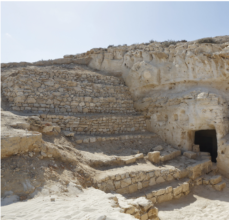
Fig. 20. Taposiris Magna, bains ptolémaïques, protection de la berme orientale à l'extérieur de l'édifice (G. Pollin).
