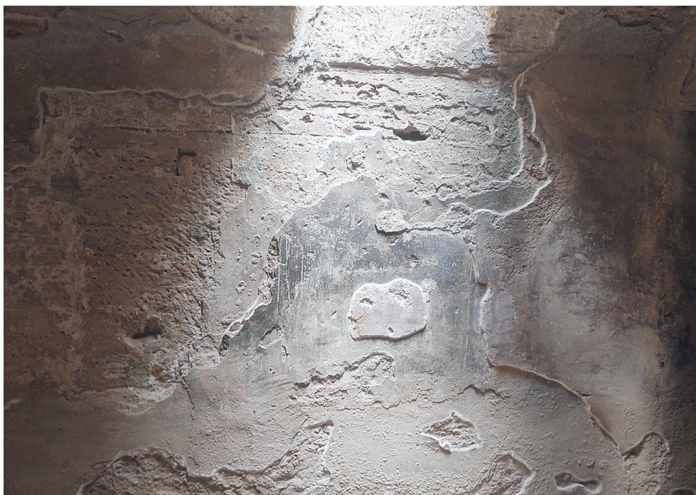
Fig. 17. Taposiris Magna, bains ptolémaïques, restauration des mortiers de la citerne n° 4 durant la campagne 2021 (B. Redon).
