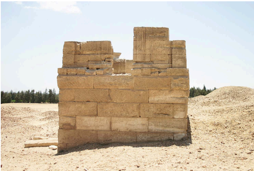
Fig. 33. La façade de la chapelle sépulcrale, aujourd'hui en hauteur par rapport au niveau du sol (2015) (S. Dhennin).
