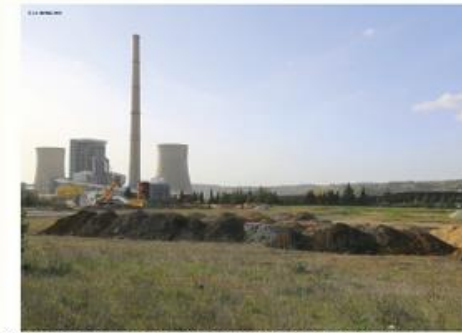
Centrale thermique de Gardanne et stock de charbon
