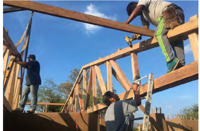
Proceso constructivo del Centro de Artes y Oficios en Ciudad Ixtepec, 2018
