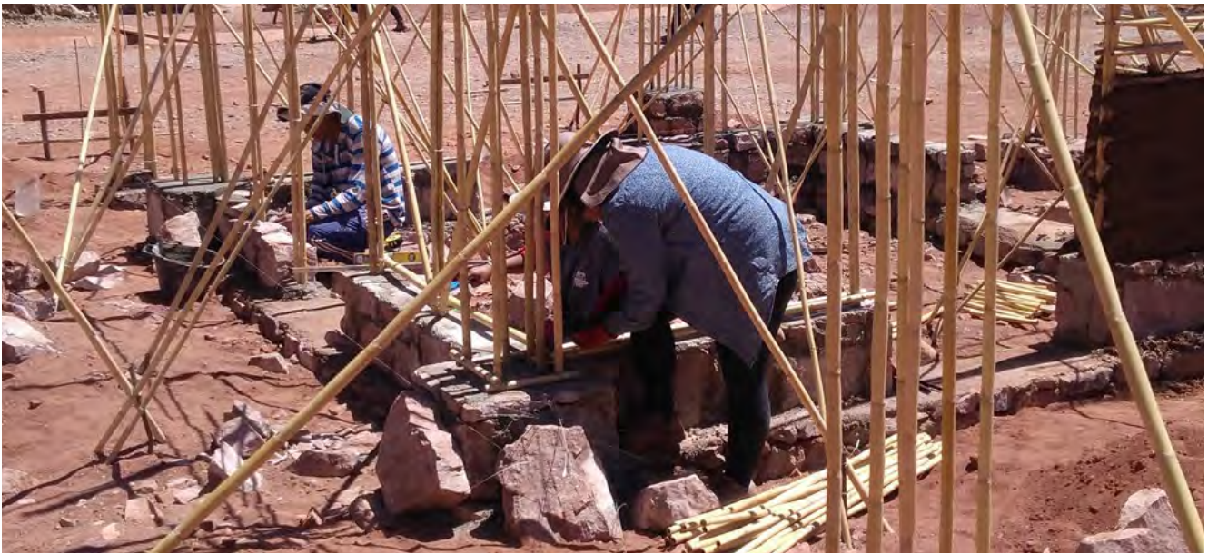
La colocación de los marcos de puertas y las instalaciones eléctricas al comienzo del tejido de los muros mejora los amarres.
