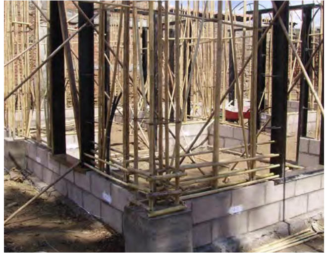
La colocación de los marcos de puertas y las instalaciones eléctricas al comienzo del tejido de los muros mejora los amarres.
