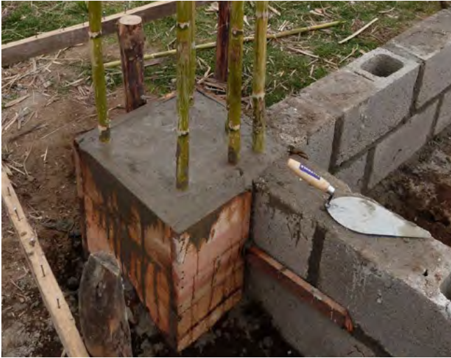
Colado de la base de las columnas al finalizar el sobrecimiento.
