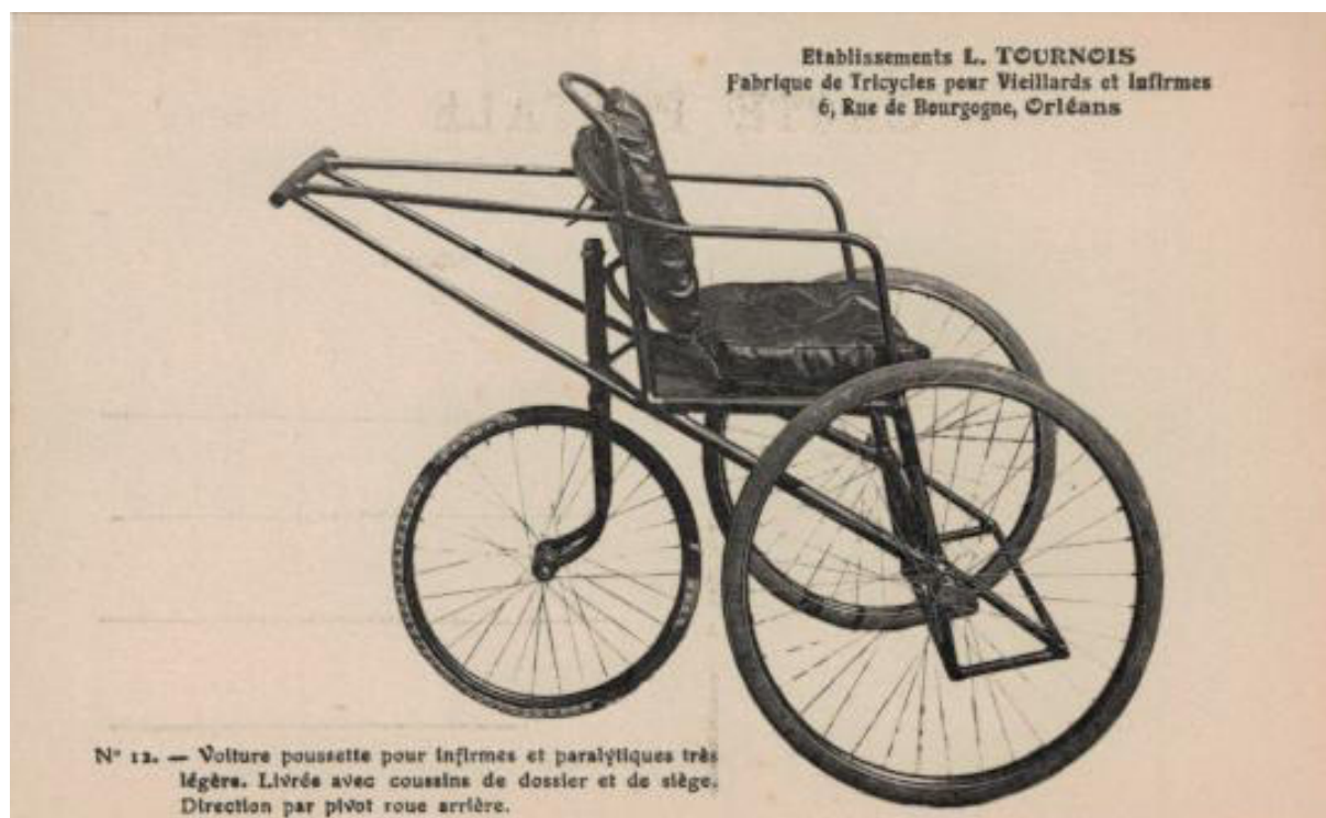
Figure 15 : Voiture pour infirmes et paralytiques très légère. © Collection JP. Martin.
