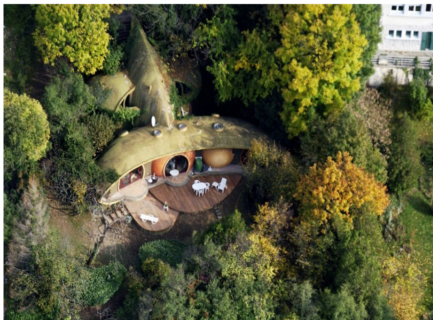
Fig. 6 • Photographie de la Maison Chanéac réalisée. Collection particulière Nelly Chanéac
