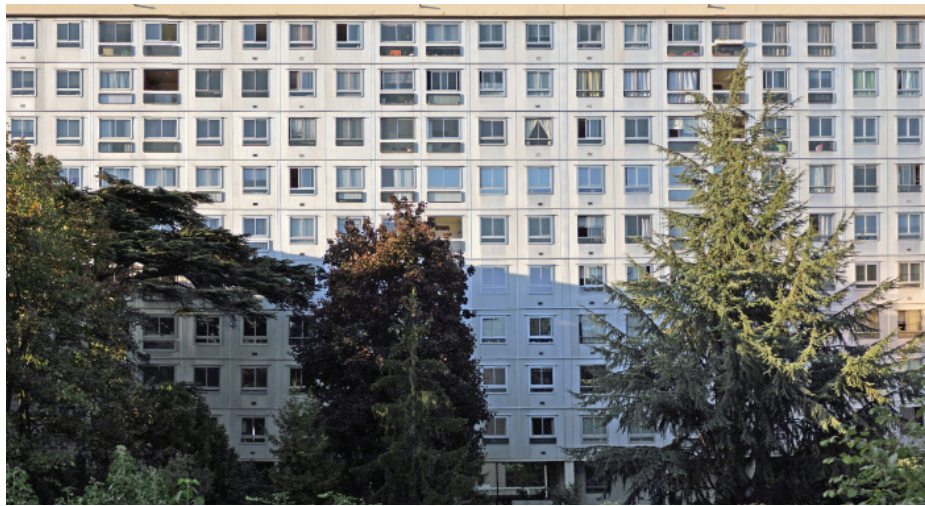
1. Les Cèdres, immeuble de logements construit en 1962, œuvre des architectes lyonnais François-Régis Cottin (1920–2013), Alain Chastel (?–1986), Marcel Dallièrre, et de Jean Prouvé (1901–1984) pour les façades, a obtenu, en 2003, le label « Patrimoine du XX e siècle », témoignant de l'intérêt porté à cet édifice (fig. 3 et 4).
