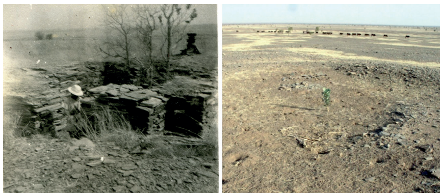
Figure 3 : Vues du mausolée central photographié en 1951 (à gauche) et en 2007 (à droite), montrant le degré de dégradation de l'édifice
