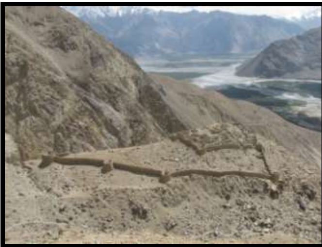
Fig.27: vue d'ensemble de la forteresse de Sumur. Cliché MAFIL.
