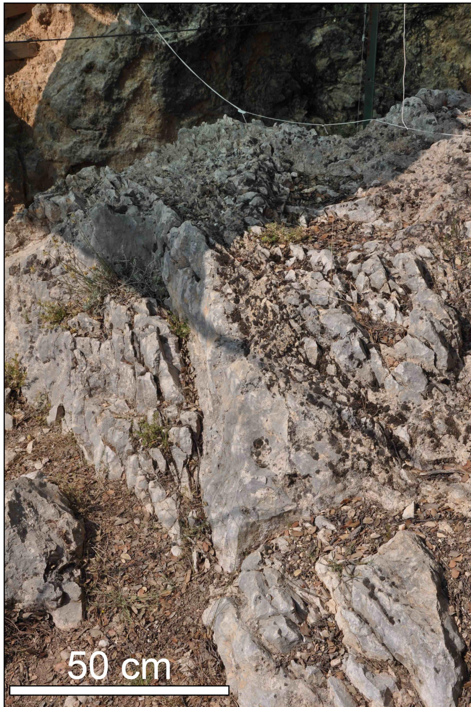
FIG. 3.6 – Vue générale d'un couloir de cisaillement subvertical intensément fracturé dans les calcaires entre les entrées des secteurs 1 et 2 des Auzières (cliché J.-L. Schneider).
