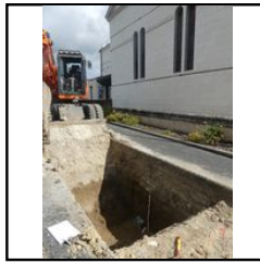
Photo 388 Vue générale de la partie sud-est de la Tr.10 - (Papin Pierre)
