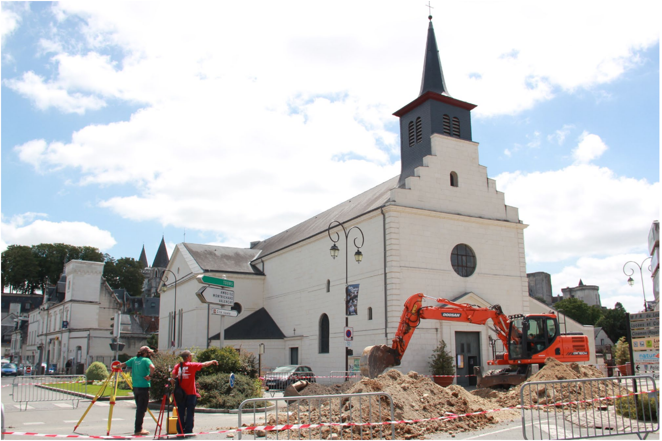
Figure 21 : Vue de l'église Saint-Antoine, pendant le creusement de la tranchée 15. Au fond, à gauche, l'actuelle poste, occupant l'ancienne chapelle de Ursulines
