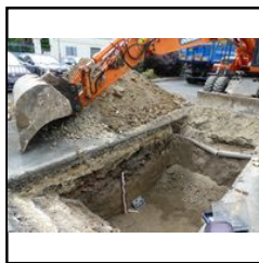
Photo 394 Vue générale de la partie sud-est de la Tr.11 - (Papin Pierre)
