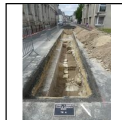
Photo 173 Vue générale de F65 et F67 (Tr.4) - (Viale Alexandre)
