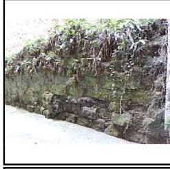
Photo 134 Parement nord du mur M2 avant dévégétalisation - (Papin Pierre)
