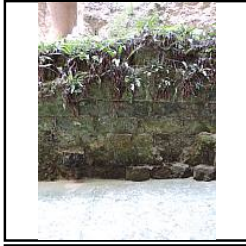
Photo 128 Parement nord du mur M2 avant dévégétalisation - (Papin Pierre)
