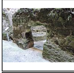
Photo 137 Nord du mur M2 détail de la porte US38 - (Papin Pierre)
