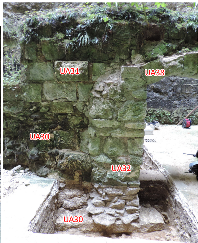
Figure 85 : photographie de détail de la reprise UA32 au sud de la porte (sondage 1)
