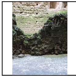
Photo 122 Parement nord du mur M2 avant dévégétalisation - (Papin Pierre)
