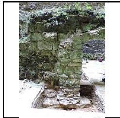
Photo 63 Sond. 1, partie sud, fondation du mur de refend - (Riou Samuel)
