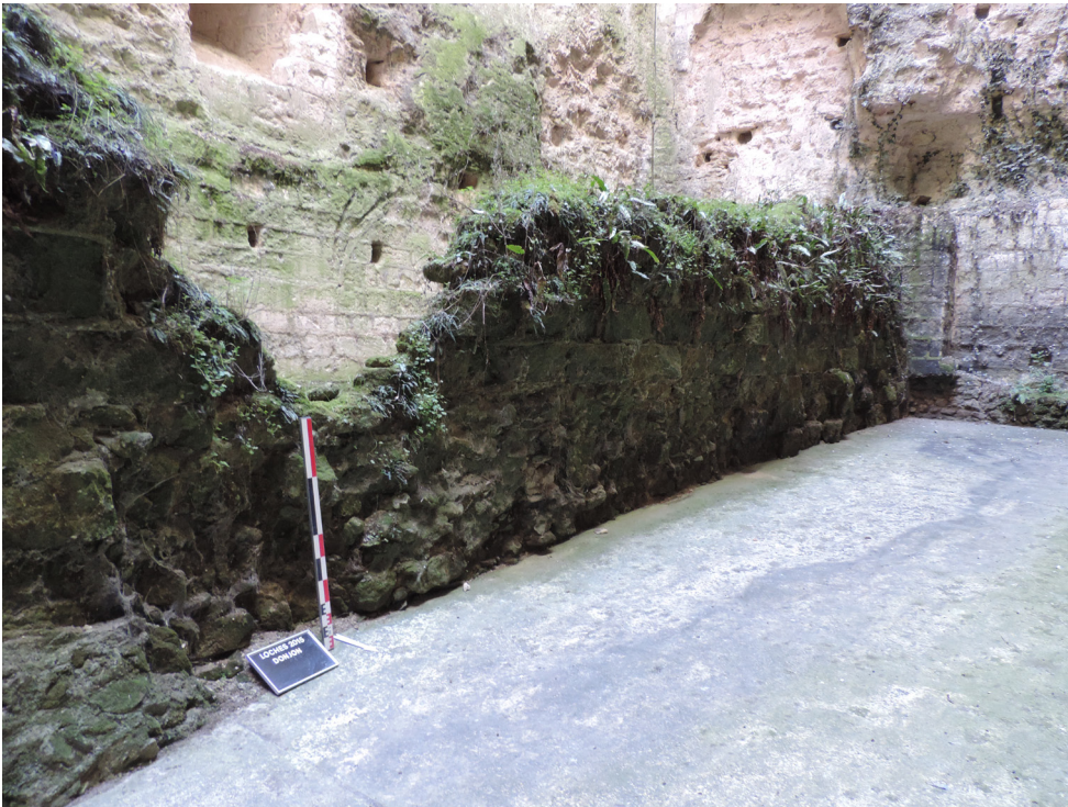
Figure 74 : photographie de la face nord du mur de refend avant nettoyage
