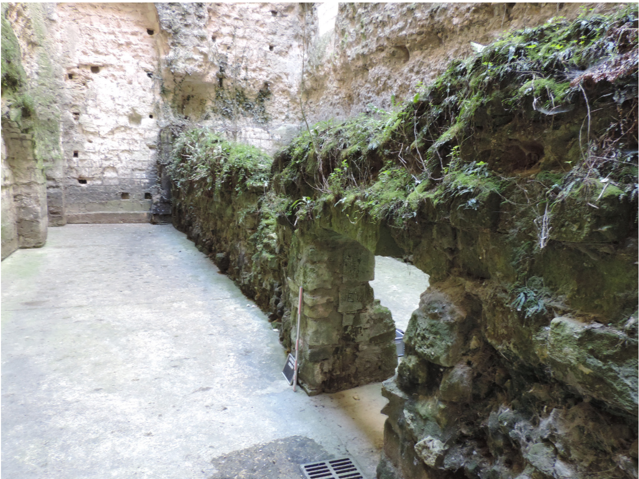
Figure 7 : photographie du mur de refend du rez-de-chaussée de la tour maîtresse avant sa restauration
