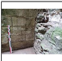
Photo 149 Parement sud M2, détail collage mur est du donjon - (Riou Samuel)
