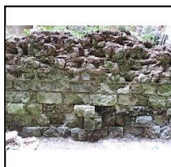
Photo 145 Parement nord mur M2 après dévégétalisation - (Riou Samuel)
