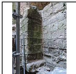
Photo 156 Détail collage pilastre US23 et mur ouest donjon - (Riou Samuel)
