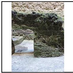
Photo 119 Parement nord du mur M2 avant dévégétalisation - (Papin Pierre)
