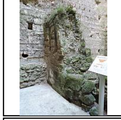
Photo 142 Nord du mur M2 détail collage mur est du donjon - (Papin Pierre)
