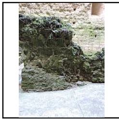
Photo 120 Parement nord du mur M2 avant dévégétalisation - (Papin Pierre)
