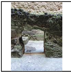
Photo 118 Parement nord du mur M2 avant dévégétalisation - (Papin Pierre)
