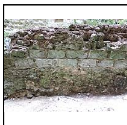
Photo 147 Parement nord mur M2 après dévégétalisation - (Riou Samuel)
