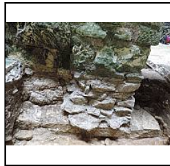
Photo 62 Sond. 1, partie sud, fondation du mur de refend - (Riou Samuel)
