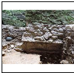
Photo 60 Sond. 1, partie nord, fondation du mur de refend - (Riou Samuel)
