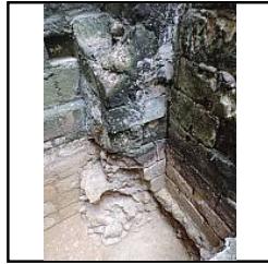
Photo 77 Sond. 2 détail fondation du pilastre US23 - (Hirn Vincent)
