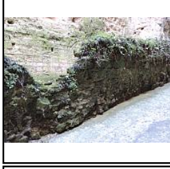
Photo 138 Vue générale nord du mur M2 avant dévégétalisation - (Papin Pierre)
