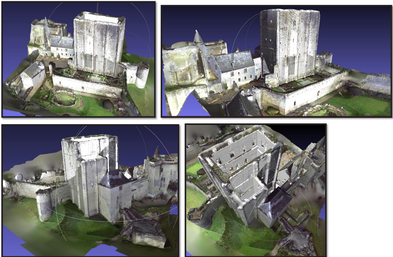
Figure 18 : relevé 3D de la tour maîtresse en 2017 (K. Pellerin)
