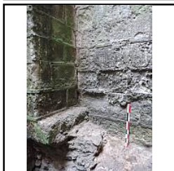
Photo 154 Détail collage pilastre US23 et mur ouest donjon - (Riou Samuel)
