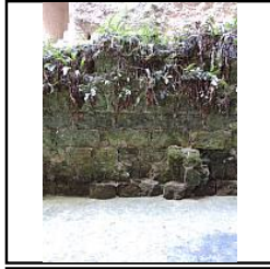
Photo 129 Parement nord du mur M2 avant dévégétalisation - (Papin Pierre)
