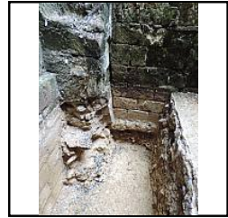
Photo 78 Sond. 2 détail fondation pilastre et mur de refend - (Hirn Vincent)
