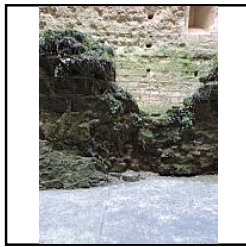
Photo 121 Parement nord du mur M2 avant dévégétalisation - (Papin Pierre)
