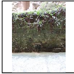
Photo 127 Parement nord du mur M2 avant dévégétalisation - (Papin Pierre)
