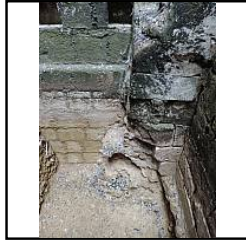
Photo 81 Sond. 2 détail fondation du pilastre US23 - (Hirn Vincent)
