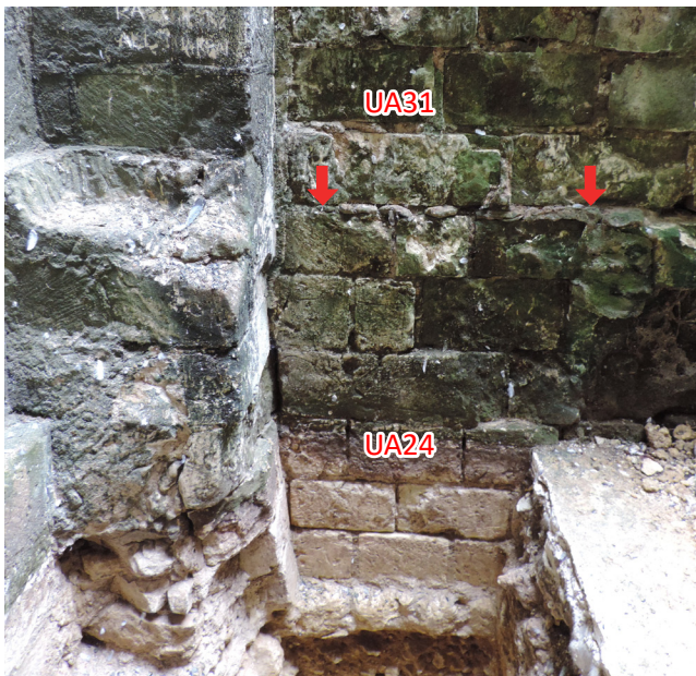
Figure 78 : photographie de détail de partie basse du mur de refend mise au jour dans le sondage 2 (face sud) (les flèches indiquent la limite entre les deux phases principales)
