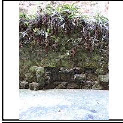
Photo 131 Parement nord du mur M2 avant dévégétalisation - (Papin Pierre)
