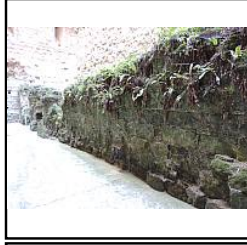
Photo 135 Vue générale nord du mur M2 avant dévégétalisation - (Papin Pierre)
