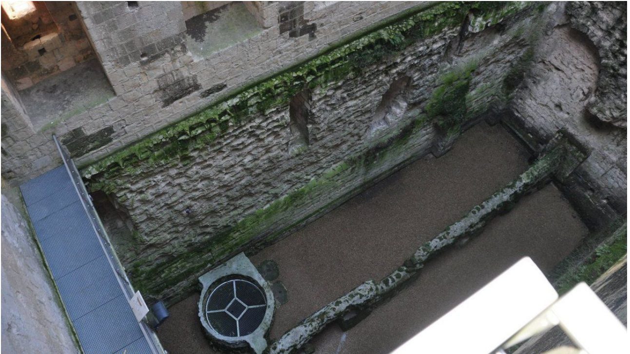
Figure 30 : photographie du rez-de-chaussée de la grande tour, avec le mur de refend et le puits (photo prise après la restauration de 2015)
