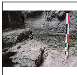
Photo 155 Détail fondation mur ouest du donjon - (Riou Samuel)
