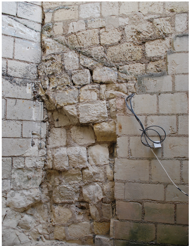
Figure 62 : détail d'une portion du mur ouest de la chemise redécouvert en 2015, avec ses assises penchées
