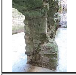
Photo 141 Nord du mur M2 détail piédroit porte US38 - (Papin Pierre)
