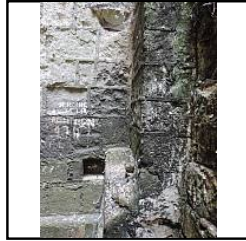
Photo 82 Sond. 2 détail du pilastre US23 - (Hirn Vincent)
