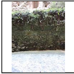
Photo 125 Parement nord du mur M2 avant dévégétalisation - (Papin Pierre)
