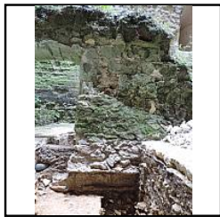
Photo 61 Sond. 1, partie nord, fondation du mur de refend - (Riou Samuel)
