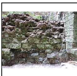
Photo 144 Parement nord mur M2 après dévégétalisation - (Riou Samuel)
