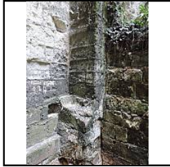
Photo 80 Sond. 2 détail du pilastre US23 - (Hirn Vincent)
