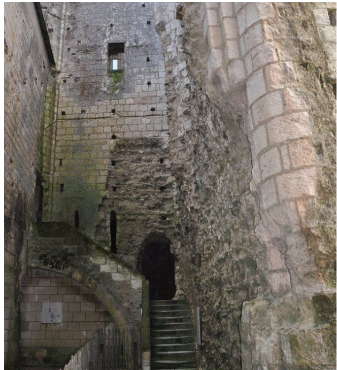
Figure 28 : photographie de l'accès d'origine par la face ouest de petite tour
