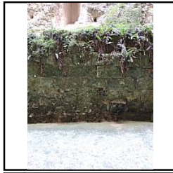
Photo 126 Parement nord du mur M2 avant dévégétalisation - (Papin Pierre)
