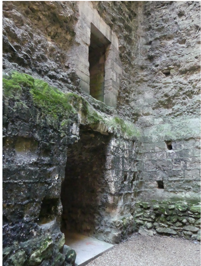
Figure 27 : photographie des accès récents percés entre la petite et la grande tour
