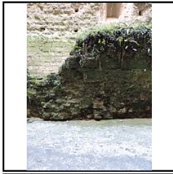
Photo 123 Parement nord du mur M2 avant dévégétalisation - (Papin Pierre)
