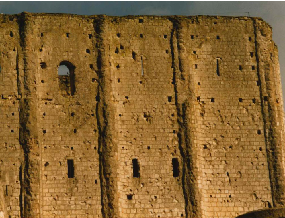
Figure 34 : photographie de la face sud du donjon (De Saint-Jouan, 1988), avec les traces de grilles sur les fenêtres du niveau 2
