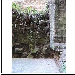
Photo 133 Parement nord du mur M2 avant dévégétalisation - (Papin Pierre)
