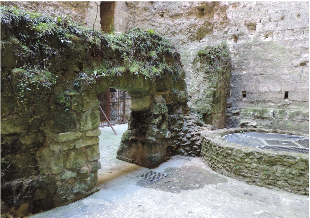
Figure 31 : photographie du mur de refend, sa porte, et le puits (avant la restauration de 2015)
