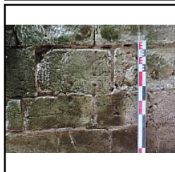
Photo 152 Parement nord mur M2 après dévégétalisation - (Riou Samuel)
