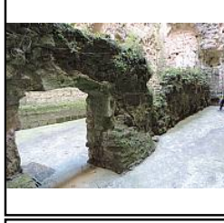
Photo 140 Vue générale nord du mur M2 avant dévégétalisation - (Papin Pierre)
