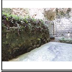
Photo 136 Vue générale nord du mur M2 avant dévégétalisation - (Papin Pierre)
