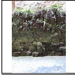
Photo 130 Parement nord du mur M2 avant dévégétalisation - (Papin Pierre)
