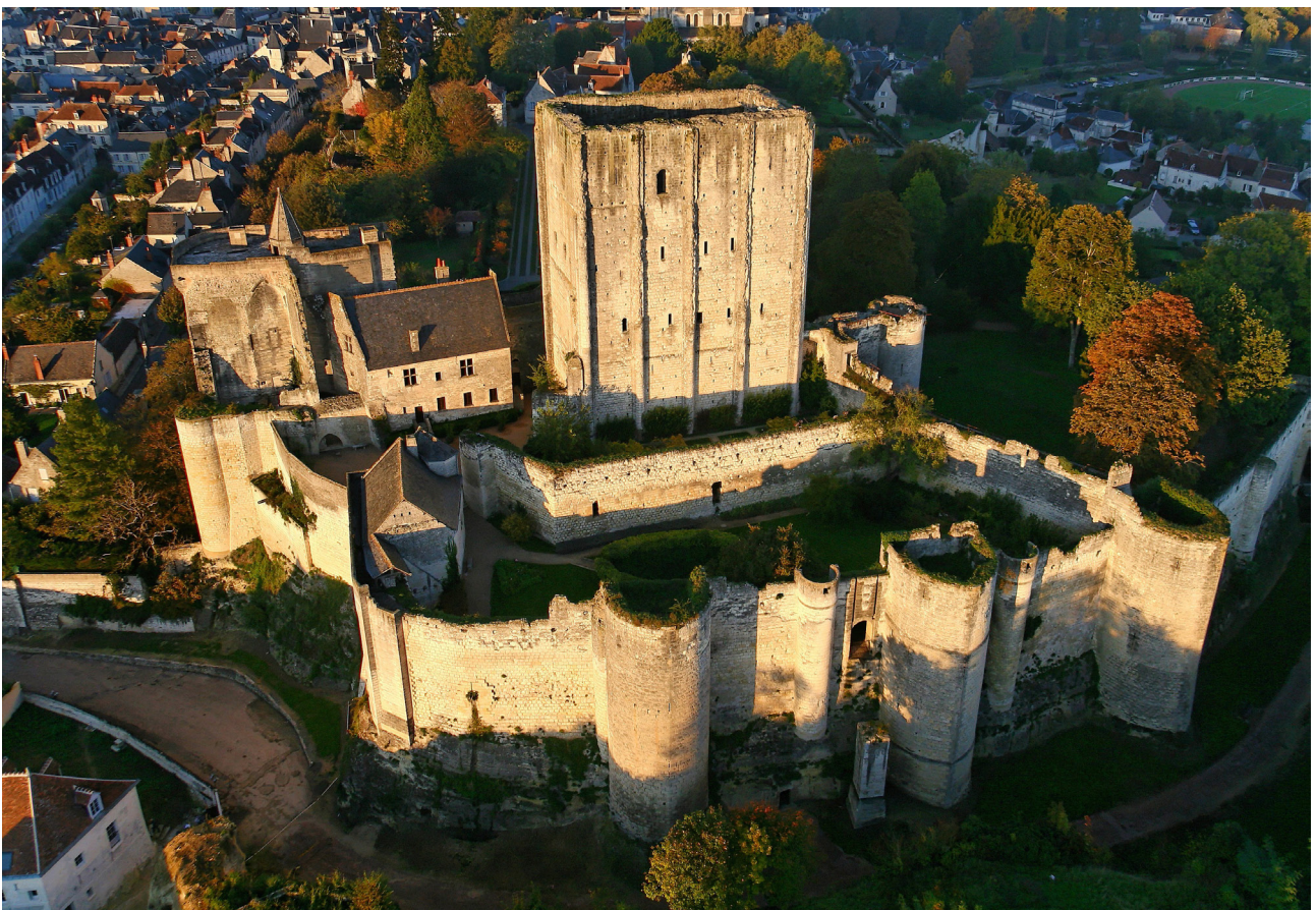
Figure 6 : photographie du « site du donjon » de Loches (photo : CD37)
