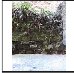
Photo 132 Parement nord du mur M2 avant dévégétalisation - (Papin Pierre)
