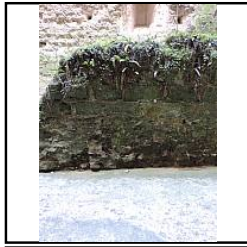
Photo 124 Parement nord du mur M2 avant dévégétalisation - (Papin Pierre)
