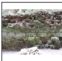
Photo 146 Parement nord mur M2 après dévégétalisation - (Riou Samuel)
