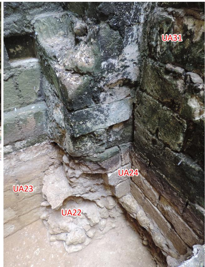
Figure 79 : photographie de détail de l'insertion de la partie basse de la maçonnerie du mur de refend dans le pilastre (sondage 2)
