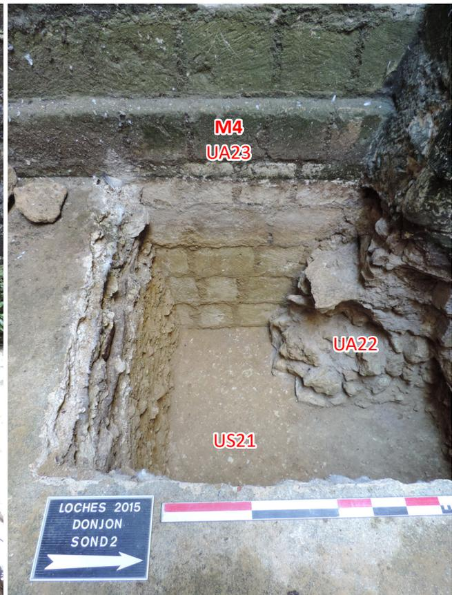
Figure 60 : fondation du mur ouest de la tour maîtresse dégagée dans le sondage 2 : parement de moyen appareil très bien conservé
