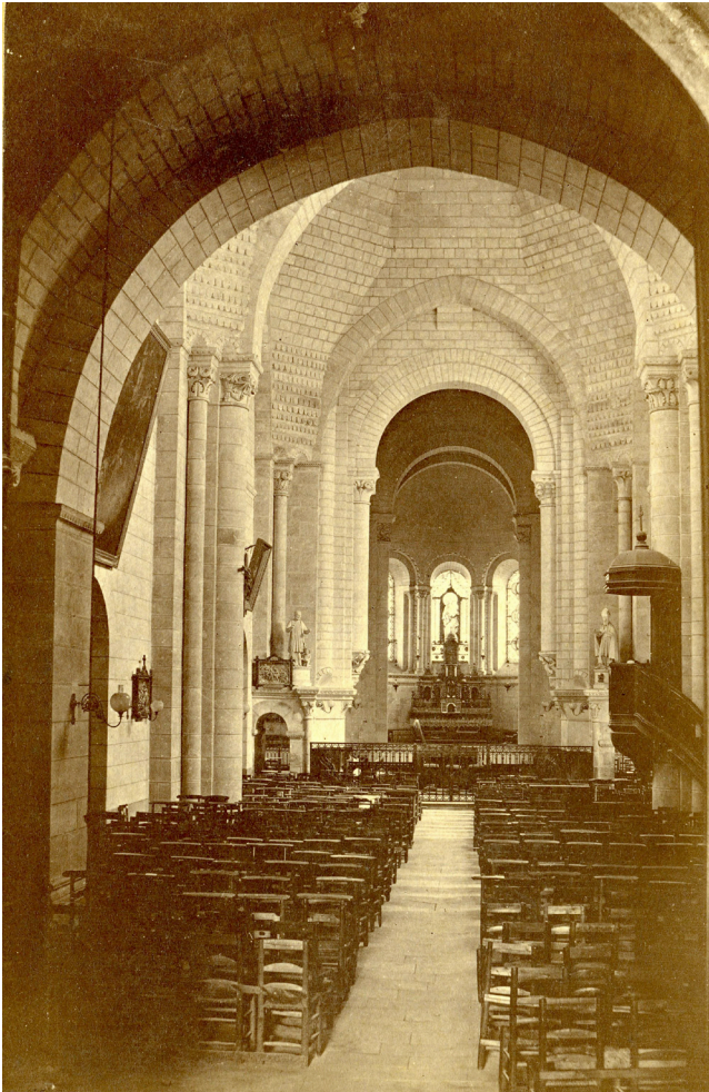
Figure 144 : photographie ancienne de la nef de la collégiale, avant les travaux de 1869-1874, avec un sol en carreaux de terre cuite (ADIL 13Fi0078)
