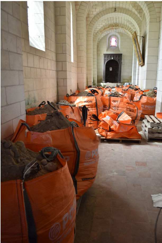
Figure 26 : Stockage provisoire des sols et des déblais en sacs à gravats, dans le bas-côté sud de l'église.
