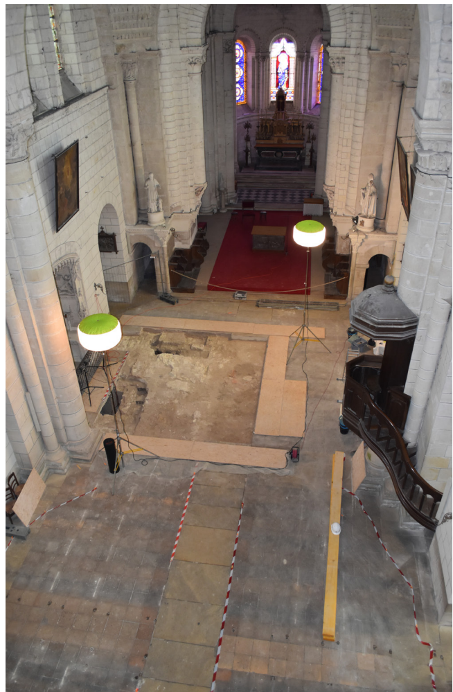
Figure 31 : Photographie générale de l'ouverture réalisée dans la nef de la collégiale en 2019
