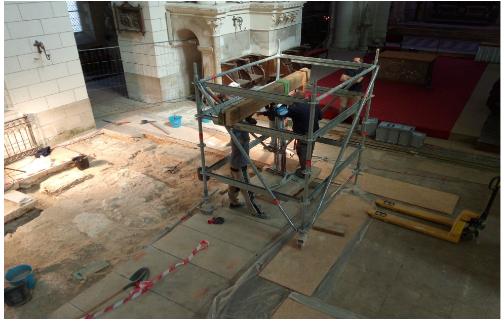
Figure 25 : Dépose des sols (par l'entreprise agréée MH, Billon SA) et premier nettoyage des vestiges sous jacents
