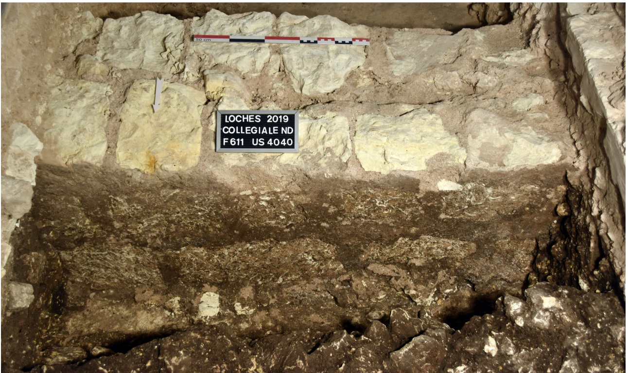
Figure 50 : Photographie du parement nord du mur M611
