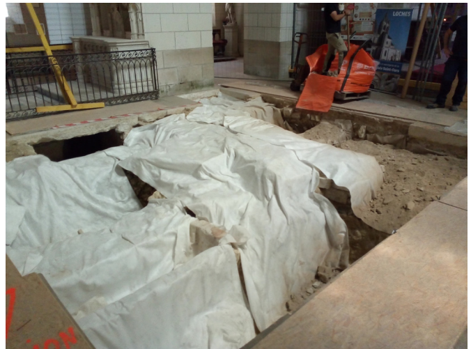
Figure 27 : Rebouchage des fouilles en 2019 après protection des vestiges par du géotextile
