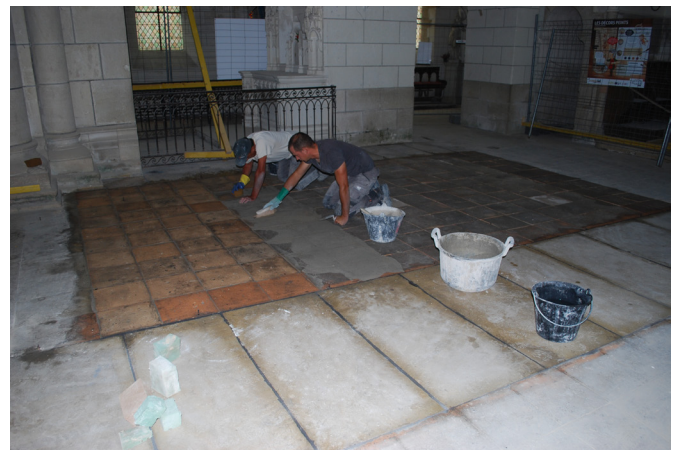
Figure 28 : Répose des sols (par l'entreprise agréée MH, Billon SA)
