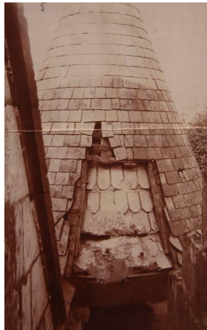
Fig. 21 : Photographie de la couverture en écailles de pierre sous la toiture d'ardoise de la tourelle d'angle nord-ouest (MAP, Photothèque, 84/37/1015 - cliché S. Bourocher).
