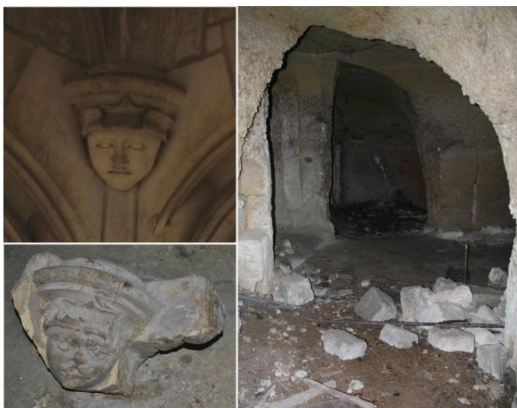
Fig. 22 : Culot restauré en place et culot d'origine déposé dans la cave souterraine (clichés P. Papin et S. Bourocher).
