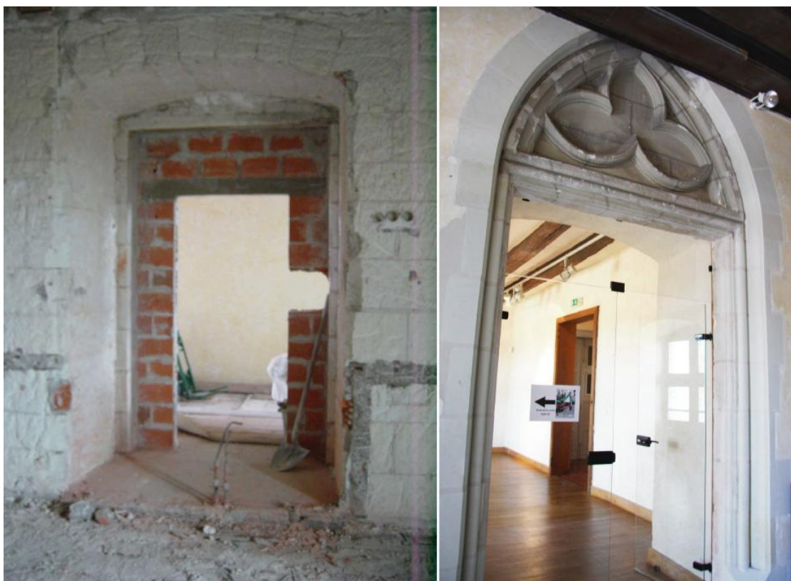
Fig. 24 : Porte percée à l'est du mur pignon séparant les deux corps de logis, avant et après restauration (clichés CG37 et S. Bourocher).
