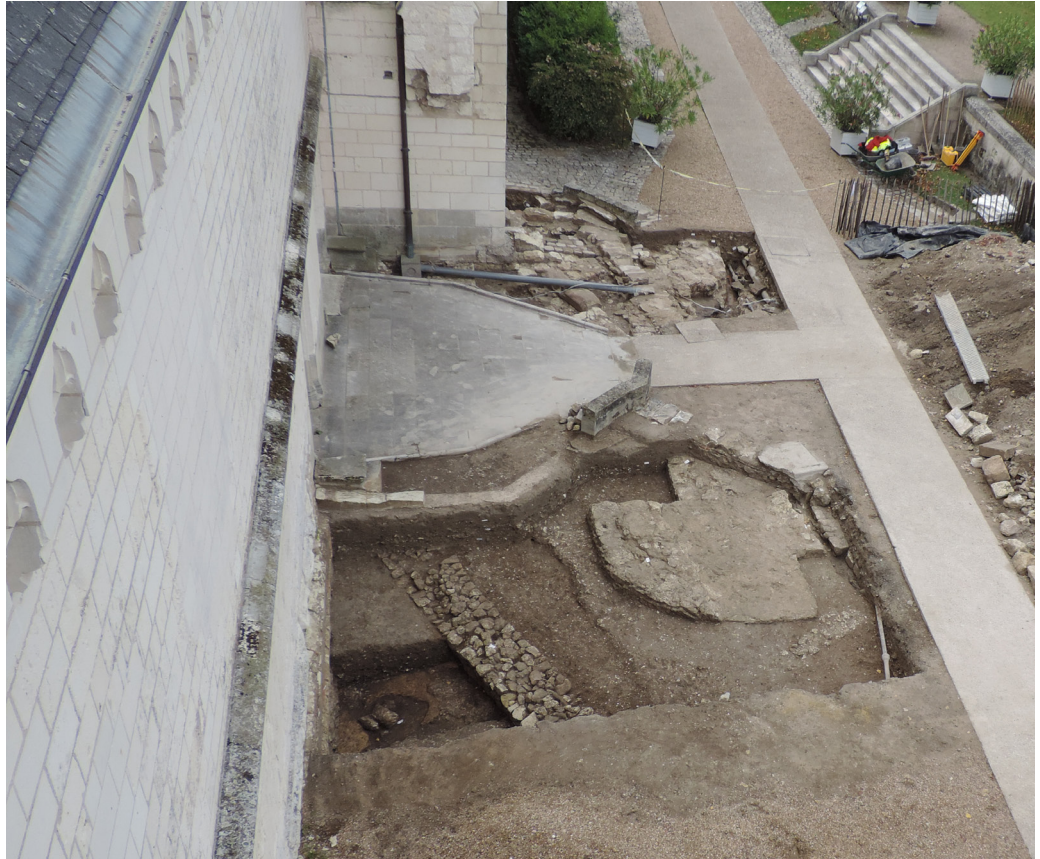
Figure 8 : Vue du chantier de fouille 2015
