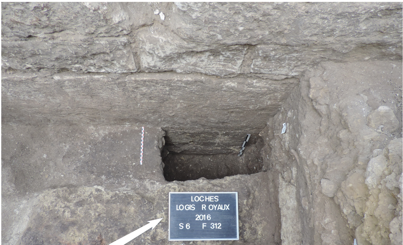
Figure 35: détail des fondations du mur M4 dans la tranchée de fondation F312, avec joints beurrés et traces d'outils
