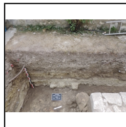
n° photo 331 Vue de la coupe berme est du secteur 6
