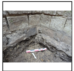
n° photo 369 Détail fondation de M4/M9 dans sondage profond
