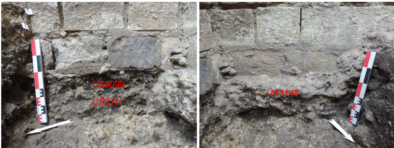
Figure 29 : Fondations des murs M4 (à gauche, reposant sur les couches 3099 et 3111) et M9 (à droite, avec sa semelle posée sur le substrat)
