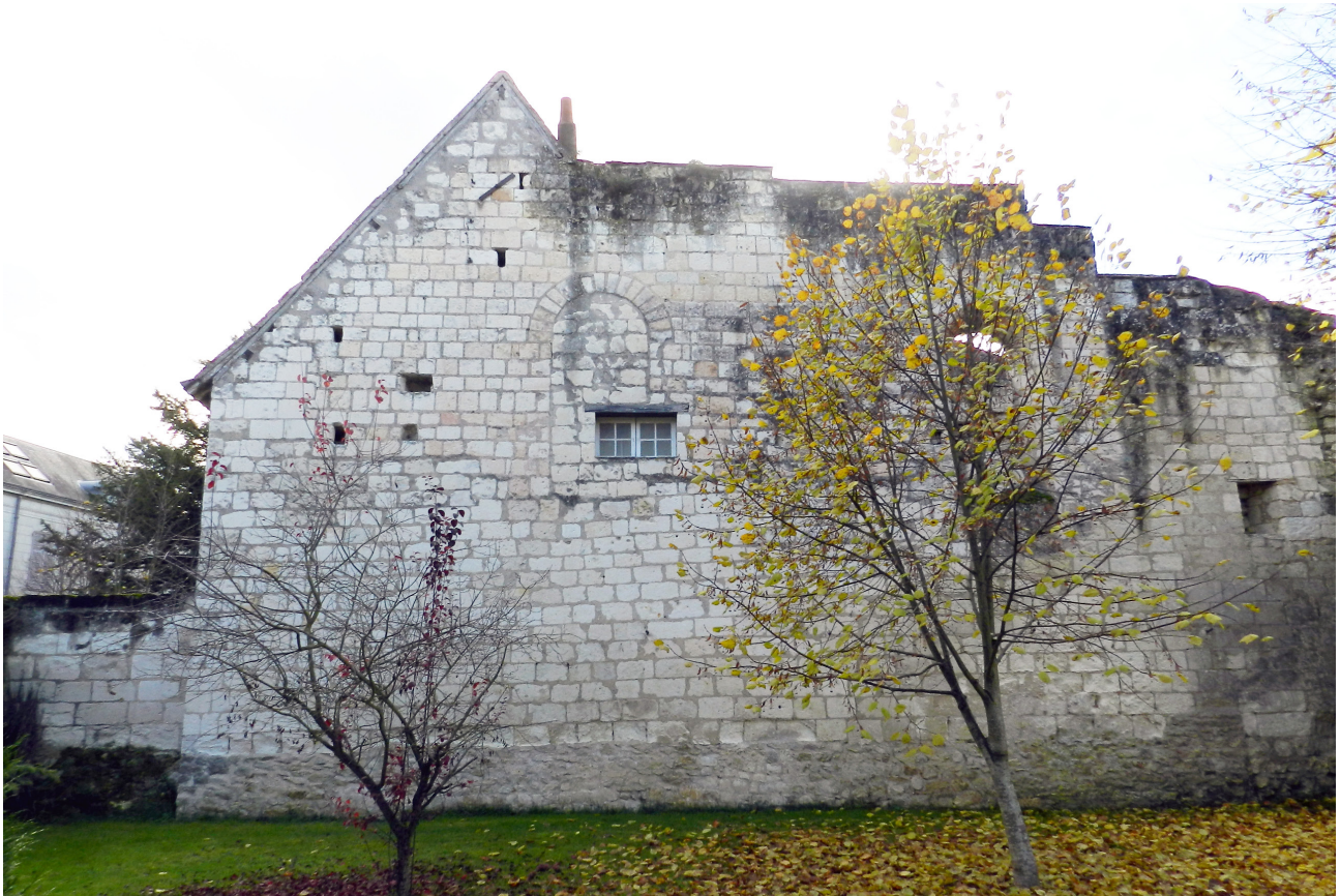
Figure 7 : Photographie du « mur à fenêtres romanes » (2013)
