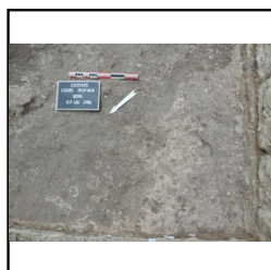
n° photo 373 Semelle de mortier contre M9 (3116)
