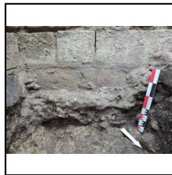
n° photo 368 Détail fondation de M9 dans sondage profond
