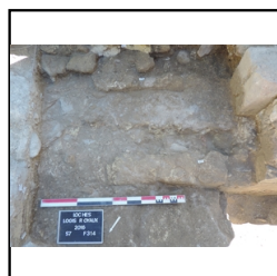
n° photo 259 Seuil du portail d'origine abîmé (3063)
