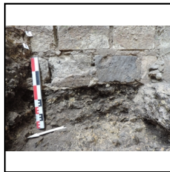
n° photo 367 Détail fondation de M4 dans sondage profond
