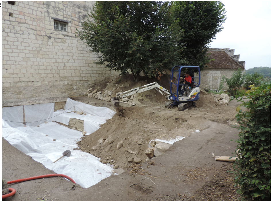
Figure 14 : Vue du rebouchage en cours, avec protection des vestiges par du géotextile
