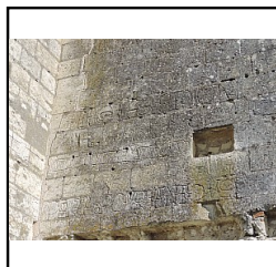
Photo 30 détail du parement avec graffitis, M4, niveau 3 - (Pellerin Kevin)
