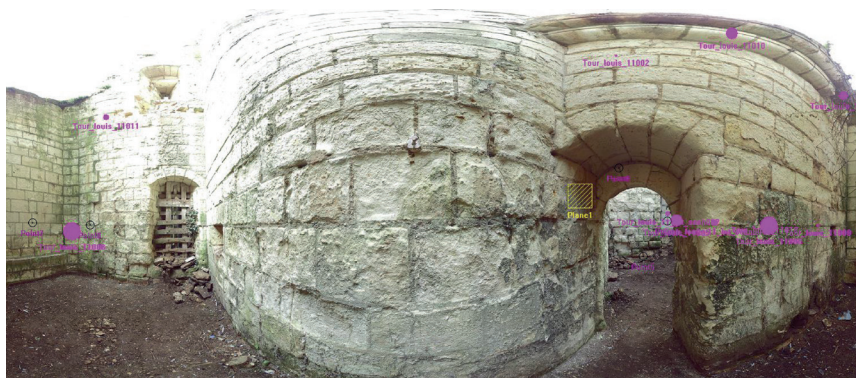
Figure 11 : Exemple d'un relevé brut au scan 3D, dans l'aile sud de la «Tour Neuve»
