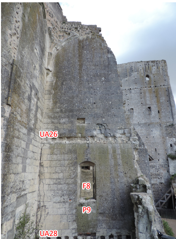
Figure 63 : Vue des restes du mur est, aux niveaux 2 et 3 de l'aile sud (M4)
