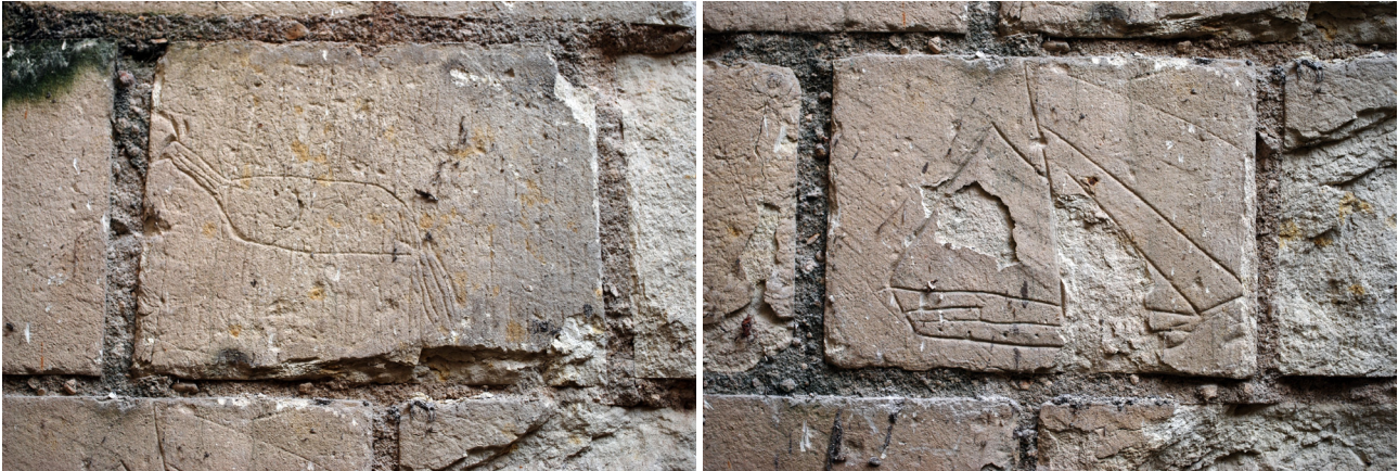
Figure 71 : Exemples de graffitis, redécouverts lors des travaux de démolition des sanitaires en 2017, dans l'espace adjacent à l'est de l'aile sud de la «Tour Neuve» (M6, UA95)
