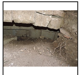
Photo 49 Sondage 1, détail encorbellement de M2 - (Riou Samuel)
