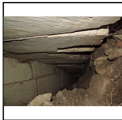
Photo 52 Sondage 1, détail encorbellement de M2 - (Riou Samuel)
