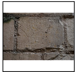
Photo 81 Détail des graffitis sur le mur M6 - (Papin Pierre)
