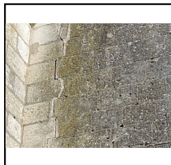
Photo 38 détail du parement avec graffitis, M4, niveau 3 - (Pellerin Kevin)
