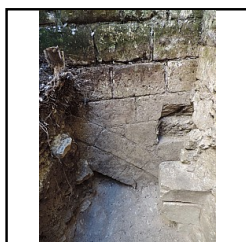
Photo 58 Sondage 2, détail arc à double rouleau P7 - (Riou Samuel)
