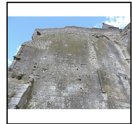
Photo 19 détail du parement, M2, niveau 3 - (Pellerin Kevin)
