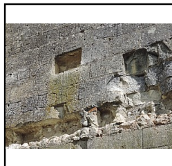
Photo 36 détail du parement avec graffitis, M4, niveau 3 - (Pellerin Kevin)
