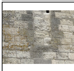
Photo 33 détail du parement avec graffitis, M2, niveau 3 - (Pellerin Kevin)
