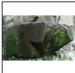
Photo 105 Détail du corbeau de la cheminée CH4 - (Pellerin Kevin)
