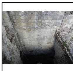
Photo 20 détail du parement, M2, niveau 1, pièce ouest - (Pellerin Kevin)
