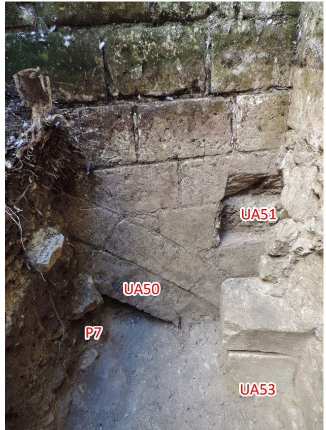
Figure 55 : Vue de détail du mur M4, mis au jour dans le sondage 2, avec l'arc UA50 (P7)
