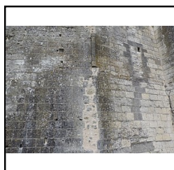
Photo 22 Parement du mur M2, niveau 2/3 - (Pellerin Kevin)
