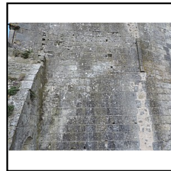
Photo 18 détail du parement, M2, niveau 2/3 - (Pellerin Kevin)
