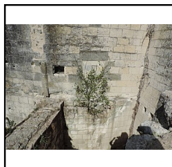
Photo 26 détail porte P16 et 14, niveau 1, M2 - (Pellerin Kevin)
