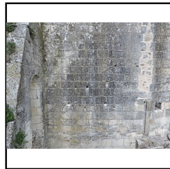
Photo 17 détail du parement, M2, niveau 2 - (Pellerin Kevin)
