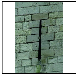
Photo 115 Détail de l'ET3, vue depuis l'extérieur - (Pellerin Kevin)
