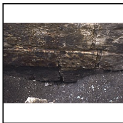
Photo 92 Sondage 3 : détail de l'arc à double rouleau P7 - (Papin Pierre)
