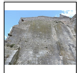
Photo 19 détail du parement, M2, niveau 3 - (Pellerin Kevin)
