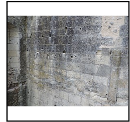
Photo 14 détail du parement avec graffitis, M2, niveau 1 - (Pellerin Kevin)
