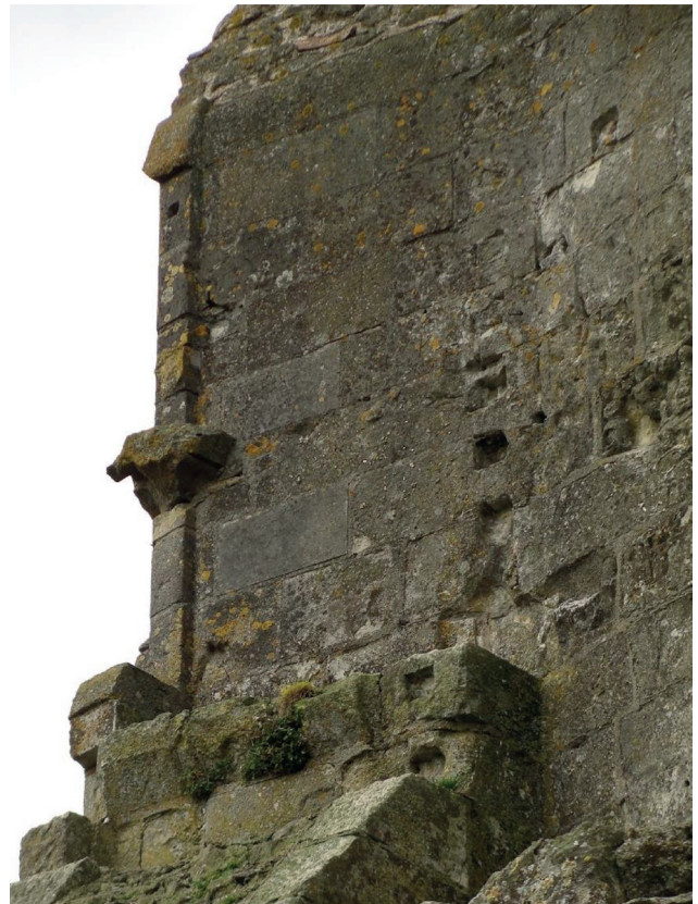
Figure 67 : Vue de détail des restes de la fenêtre à meneau et à coussiège F12, mur ouest de l'aile sud (M3)
