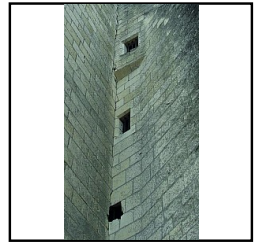
Photo 117 Angle des murs M4 et M6, partie haute - (Pellerin Kevin)
