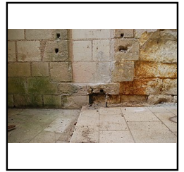
Photo 86 Détail partie basse de la fenêtre F10 - (Papin Pierre)
