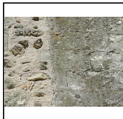
Photo 39 détail du parement avec graffitis, M2, niveau 3 - (Pellerin Kevin)
