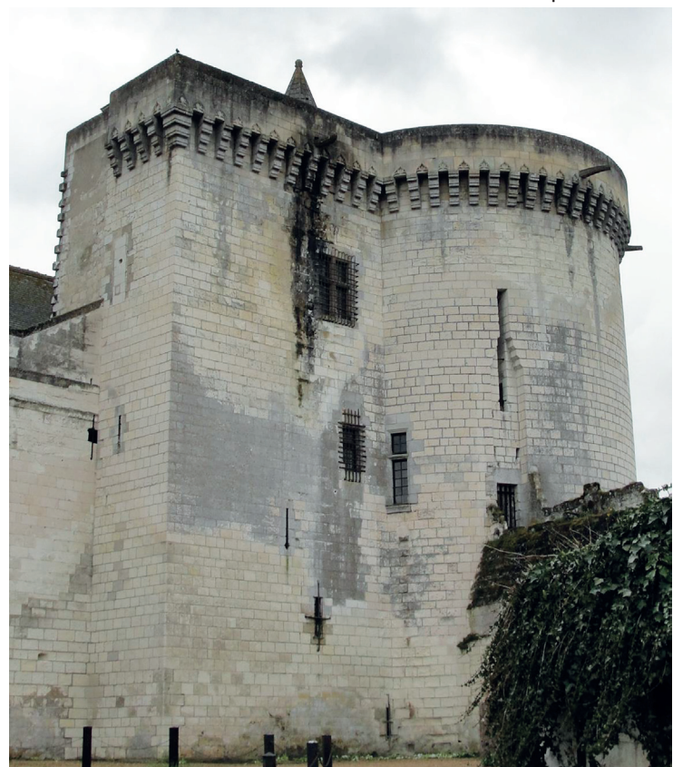
Figure 45 : Vue de la «Tour Neuve» depuis le nord
