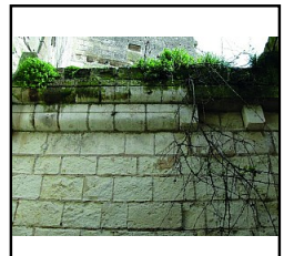
Photo 111 Détail de la restauration de l'arase de M1 - (Pellerin Kevin)
