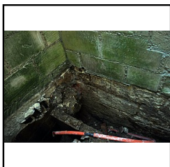
Photo 96 Sondage 3 : angle de M4 et M9, partie basse - (Papin Pierre)
