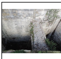
Photo 21 détail de l'arase du mur M1 - (Pellerin Kevin)
