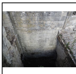
Photo 20 détail du parement, M2, niveau 1, pièce ouest - (Pellerin Kevin)
