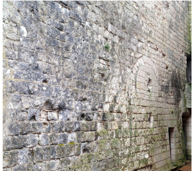
Figure 39 : Vue de la chemise sur le front nord, avec la série d'arcades (bouchées) dans la surélévation
