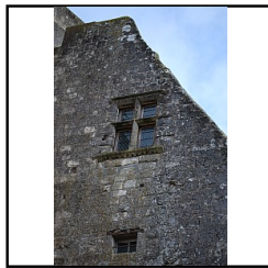
Photo 89 Détail des ouvertures F25 et F28 dans M7 - (Papin Pierre)
