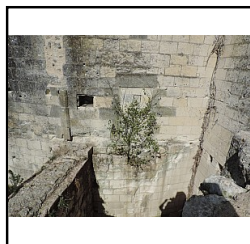
Photo 26 détail porte P16 et 14, niveau 1, M2 - (Pellerin Kevin)
