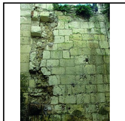
Photo 106 Détail parement conservé du rempart Henri II (M5) - (Pellerin Kevin)
