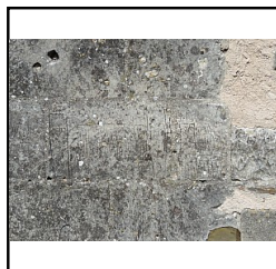
Photo 29 détail des graffitis, M2, niveau 2, pièce ouest - (Pellerin Kevin)
