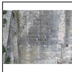
Photo 17 détail du parement, M2, niveau 2 - (Pellerin Kevin)
