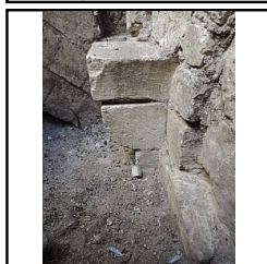
Photo 64 Sondage 2, détail corbeau de la cheminée CH6 - (Riou Samuel)
