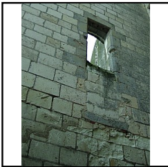
Photo 118 Détail de F8 (P9) et départ de l'escalier UA89 - (Pellerin Kevin)
