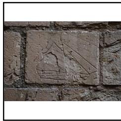
Photo 80 Détail des graffitis sur le mur M6 - (Papin Pierre)
