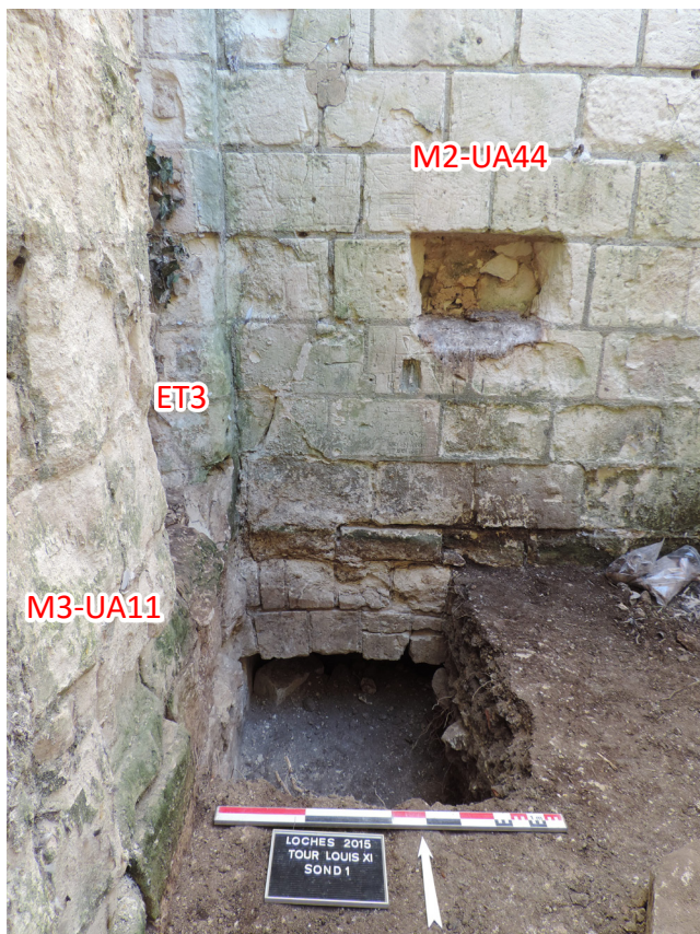
Figure 50 : Vue du sondage 1, pièce occidentale de l'aile sud de la «Tour Neuve»
