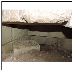
Photo 51 Sondage 1, détail encorbellement de M2 - (Riou Samuel)
