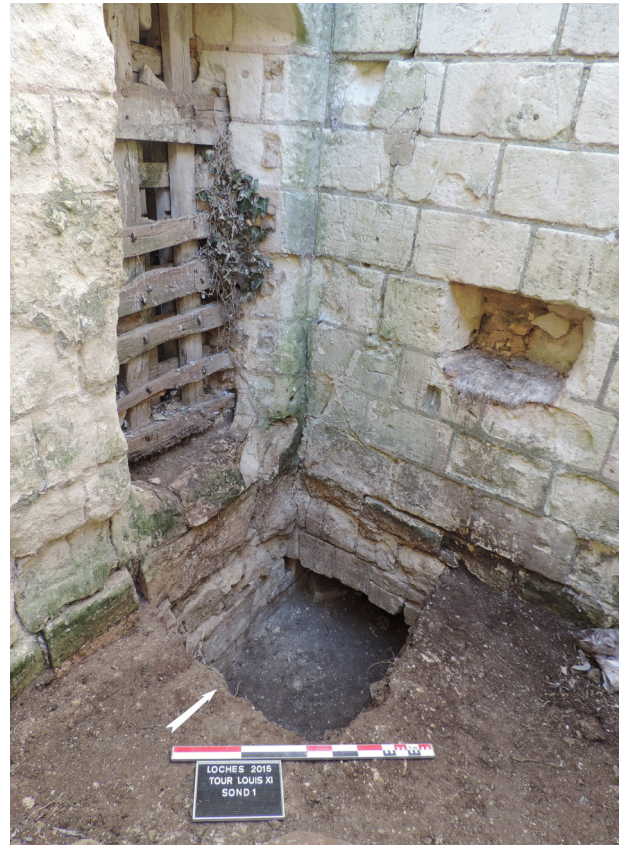
Figure 8 : Vue du sondage 1, pratiqué dans l'aile sud effondrée de la «Tour Neuve»
