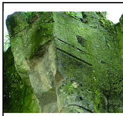
Photo 108 Détail corbeau de la cheminée CH5 - (Pellerin Kevin)
