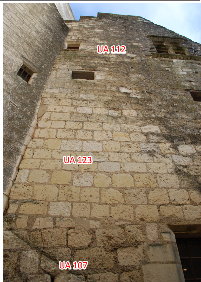
Figure 40 : Vue de la surélévation de la chemise (M7, UA 123)
