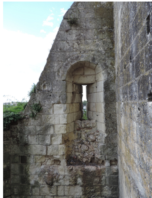
Figure 64 : Vue de l'embrasure de tir ET2, au niveau 2 de l'aile sud, mur ouest (M3)
