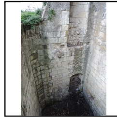
Photo 13 Partie basse du mur M3 - (Pellerin Kevin)
