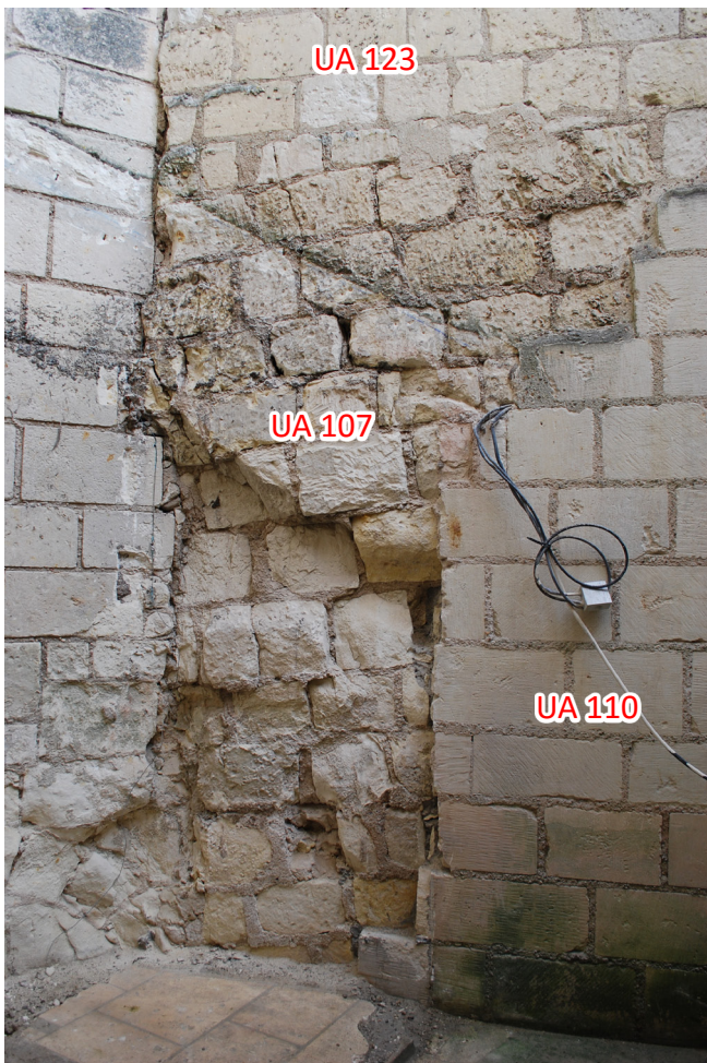
Figure 30 : portion de la chemise, avec ses assises penchées (M7, UA107), redécouverte suite aux démolitions
