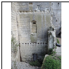
Photo 6 Partie médiane du mur M4, parement ouest - (Pellerin Kevin)
