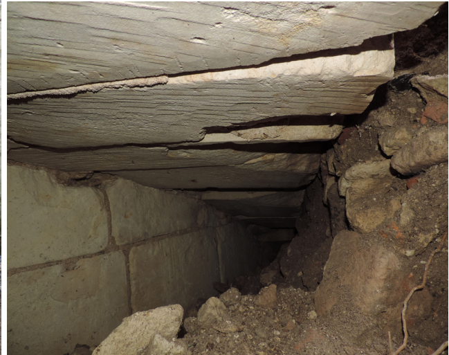
Figure 51 : Vue de détail de l'encorbellement mis au jour dans le sondage 1
