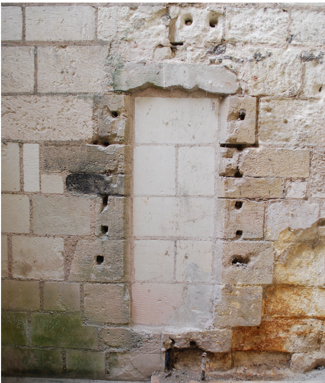
Figure 69 : Vue de la fenêtre F10, transformée en porte P29, au niveau 1 de l'aile sud, mur est (M4, parement extérieur)
