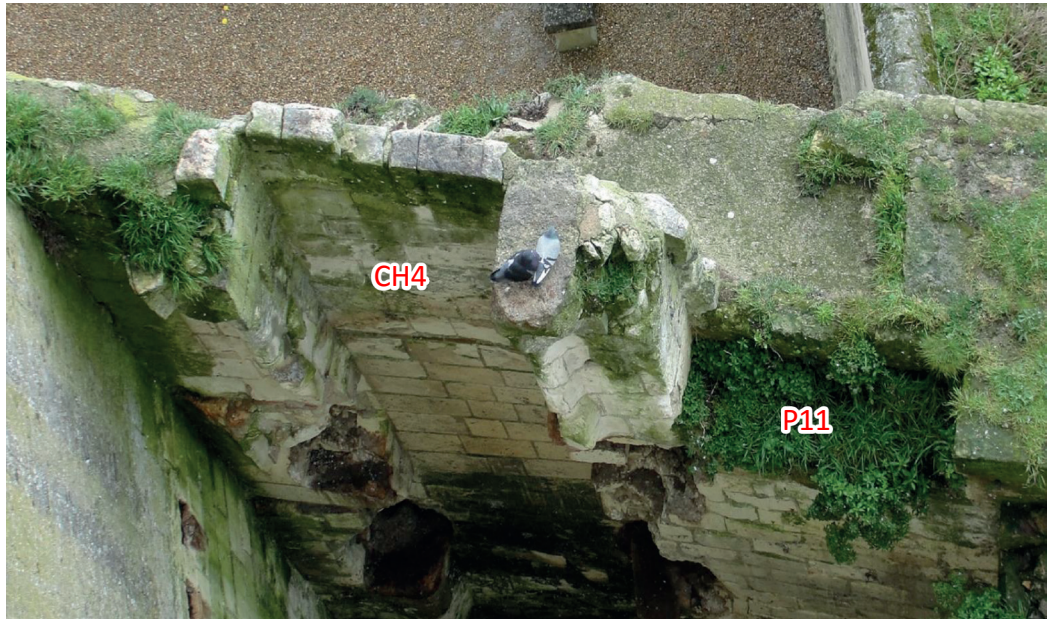
Figure 66 : Vue des restes de la cheminée CH4 et de la porte P11, sur l'arase du mur sud (M5) (cliché K. Pellerin).
