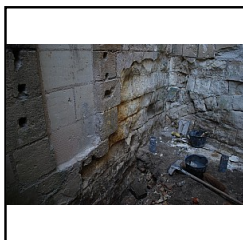
Photo 97 Sondage 3 : vue générale - (Papin Pierre)
