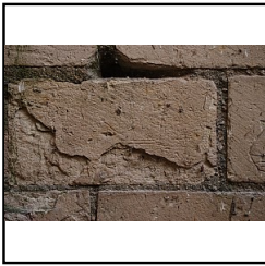
Photo 82 Détail des graffitis sur le mur M6 - (Papin Pierre)
