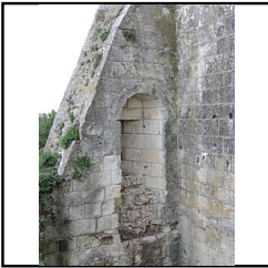
Photo 10 M3, détail embrasure de tir ET2 - (Pellerin Kevin)
