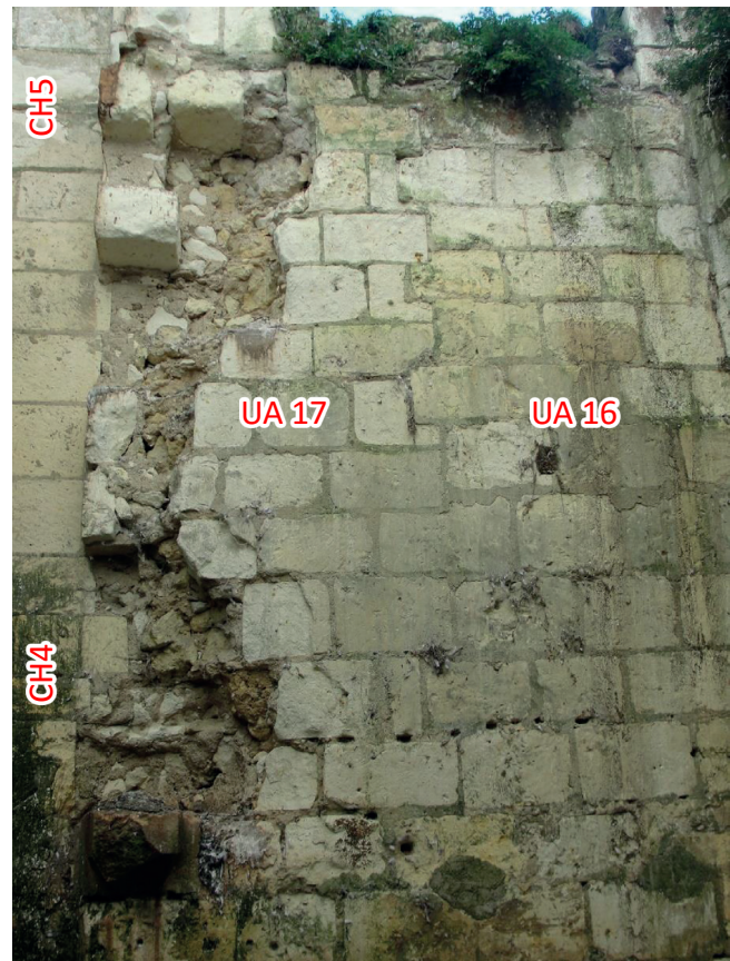
Figure 42 : Détail du parement conservé de l'enceinte « Henri II » à l'intérieur de la « Tour-Neuve » (M5, UA16), avec le coup de sabre pour l'insertion des cheminées (cliché K. Pellerin).
