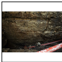
Photo 94 Sondage 3 : détail de l'arc à double rouleau P7 - (Papin Pierre)
