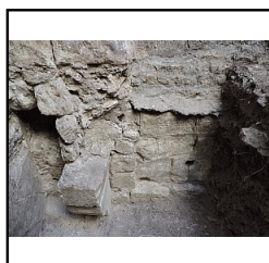
Photo 56 Sondage 2, détail cheminée CH6 et UA54 - (Riou Samuel)
