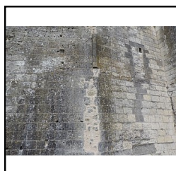
Photo 22 Parement du mur M2, niveau 2/3 - (Pellerin Kevin)
