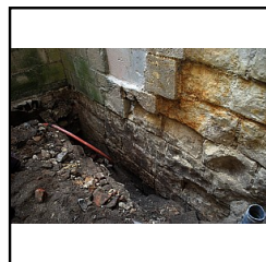
Photo 98 Sondage 3 : vue générale - (Papin Pierre)
