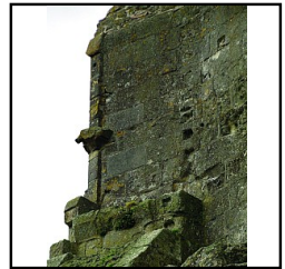
Photo 116 Détail de la fenêtre F12, M3, niveau 3 - (Pellerin Kevin)
