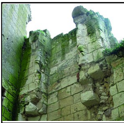
Photo 107 Détail de la cheminée CH54, M5, niveau 1 - (Pellerin Kevin)
