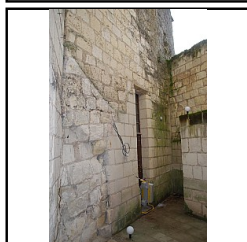
Photo 74 Mur M7, vue générale - (Papin Pierre)
