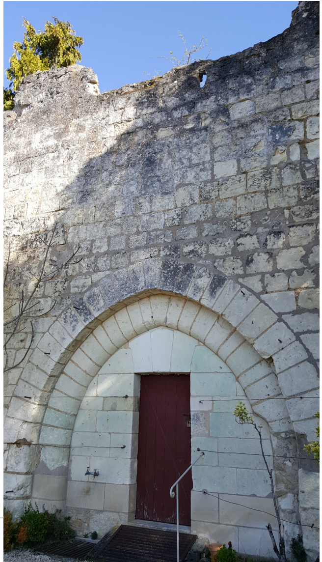
Figure 41 : Vue de la portion conservée de l'enceinte de la fin du 11 e s. au nord de la «Tour-Neuve», avec son crénelage fossilisé par une surélévation
