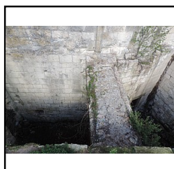
Photo 21 détail de l'arase du mur M1 - (Pellerin Kevin)
