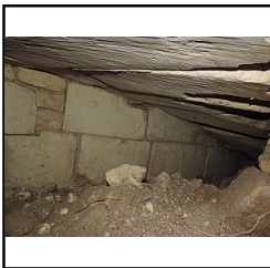
Photo 50 Sondage 1, détail encorbellement de M2 - (Riou Samuel)
