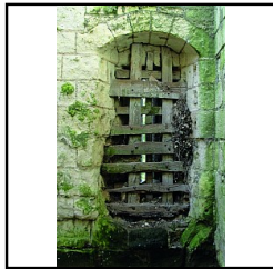
Photo 113 Détail de l'ET3, M3, niveau 1 - (Pellerin Kevin)
