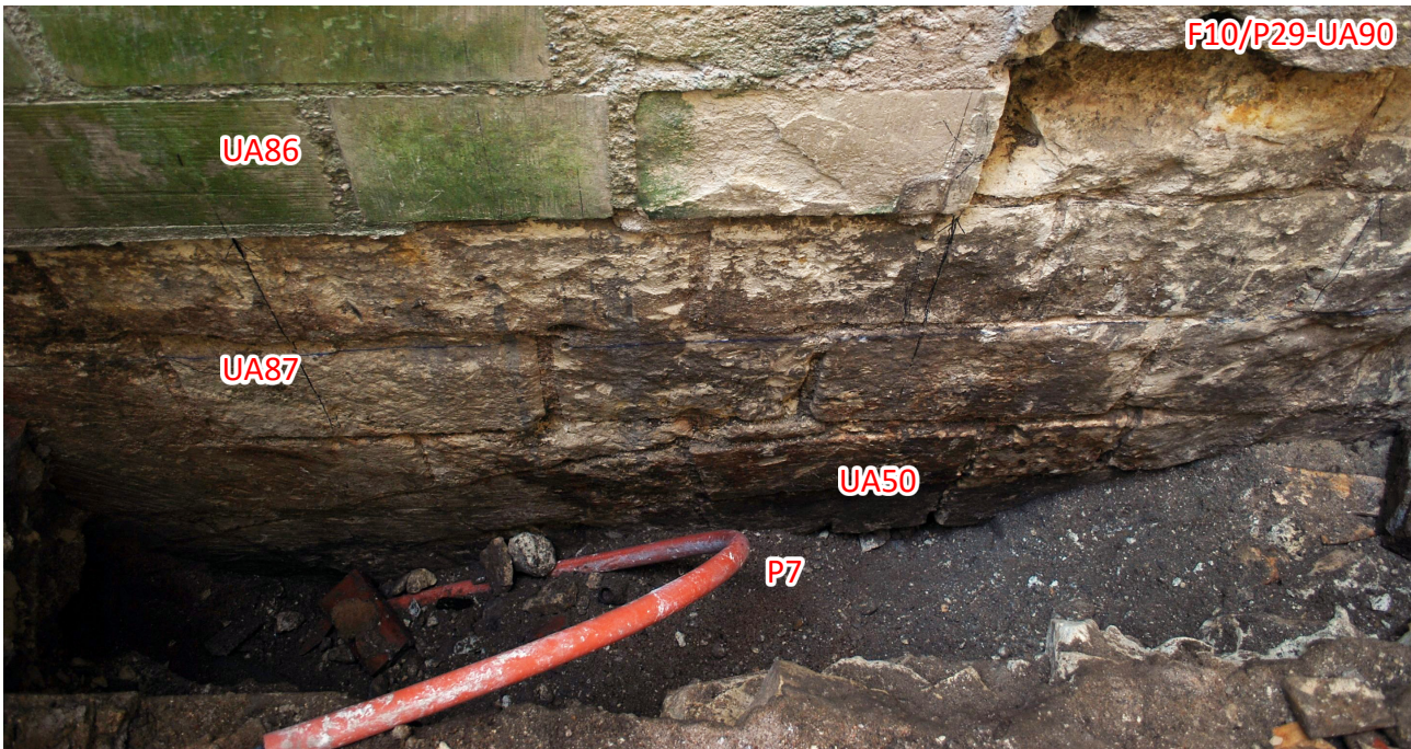
Figure 59 : Vue du sondage 3 (surveillance de travaux de février 2017), en secteur 2, avec apparition de l'arc UA 50 (P7, M4, parement est)
