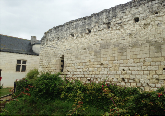
Figure 38 : Vue de la chemise sur le front sud, dont la surélévation a fossilisé le crénelage du premier état
