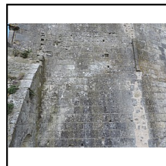
Photo 18 détail du parement, M2, niveau 2/3 - (Pellerin Kevin)
