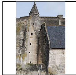
Photo 3 Vue de la zone diagnostiquée: secteur 2 - (Papin Pierre)
