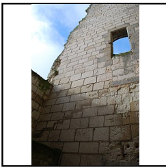
Photo 77 Parement de M4, F8/P9 et trace de l'escalier UA89 - (Papin Pierre)
