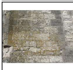
Photo 32 détail du parement avec graffitis, M2, niveau 3 - (Pellerin Kevin)
