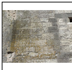
Photo 28 détail du parement avec graffitis, M2, niveau 3 - (Pellerin Kevin)
