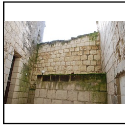
Photo 85 Le mur M8, parties ancienne (UA83) - (Papin Pierre)
