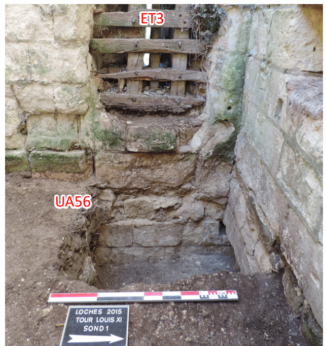
Figure 56 : Vue de détail du mur M3, mis au jour dans le sondage 1, avec la trace du niveau de plancher UA56
