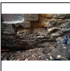
Photo 91 Sondage 3 : parement de M4, et apparition de P7 - (Papin Pierre)
