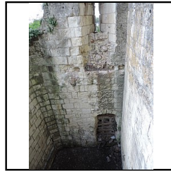
Photo 12 Partie basse du mur M3 - (Pellerin Kevin)
