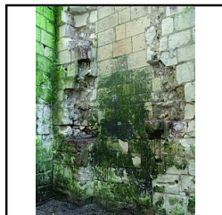
Photo 104 Détail de la cheminée CH4, M5, niveau 1 - (Pellerin Kevin)
