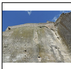
Photo 23 Parement du mur M2, niveau 3 - (Pellerin Kevin)
