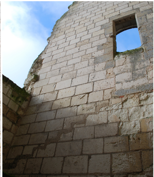
Figure 70 : Vue de la fenêtre F8, transformée en porte P9, associée à la trace d'escalier (UA89), au niveau 2 de l'aile sud, mur est (M4, parement extérieur)
