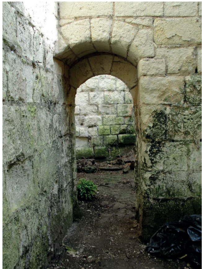
Figure 61 : Vue de la porte P1, dans le mur de refend M1 au niveau 1 de l'aile sud de la «Tour Neuve» (cliché K. Pellerin).
