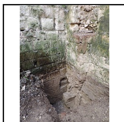
Photo 62 Sondage 2, vue générale angle M4 et M5 - (Riou Samuel)
