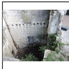
Photo 7 Partie basse du mur M4, parement ouest - (Pellerin Kevin)
