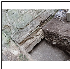
Photo 46 Sondage 1, vue de la coupe est - (Riou Samuel)
