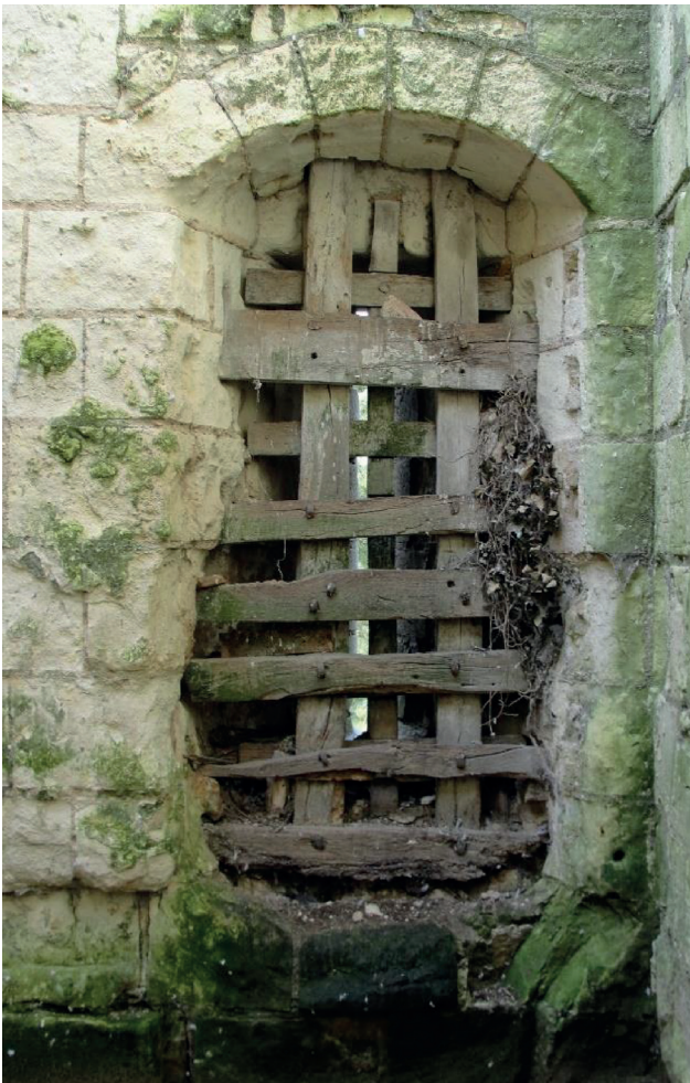
Figure 65 : Vue de l'embrasure de tir ET3, au niveau 1 de l'aile sud, mur ouest (M3) (cliché K. Pellerin).
