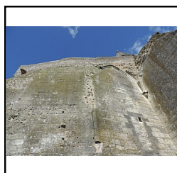
Photo 23 Parement du mur M2, niveau 3 - (Pellerin Kevin)
