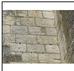
Photo 37 détail du parement avec graffitis, M2, niveau 3 - (Pellerin Kevin)
