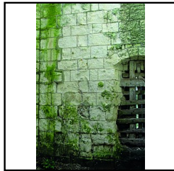
Photo 114 Détail du parement de M3, niveau 1 - (Pellerin Kevin)
