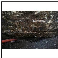
Photo 93 Sondage 3 : détail de l'arc à double rouleau P7 - (Papin Pierre)
