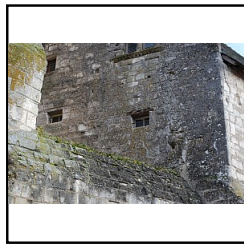
Photo 90 Détail des ouvertures F25 et F24 dans M7 - (Papin Pierre)
