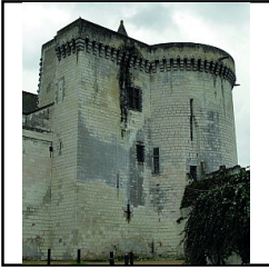
Photo 100 Vue de la tour Louis XI depuis le nord - (Pellerin Kevin)
