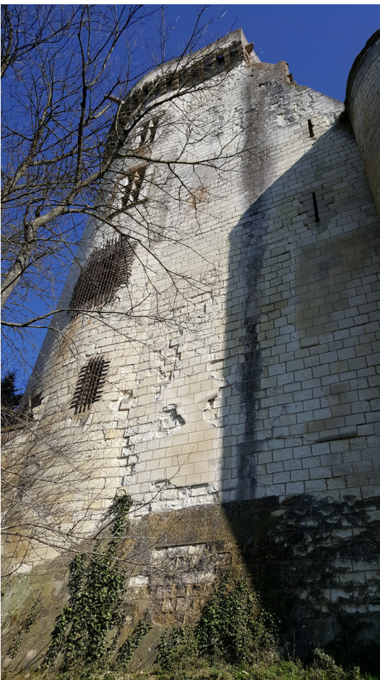
Figure 44 : Vue de la «Tour Neuve» depuis les fossés à l'ouest
