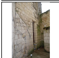
Photo 74 Mur M7, vue générale - (Papin Pierre)
