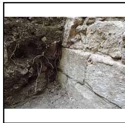
Photo 53 Sondage 1, détail coupe sud, contre M3 - (Riou Samuel)
