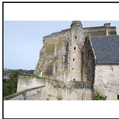
Photo 2 Vue de la zone diagnostiquée - (Papin Pierre)
